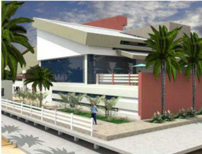
Se optará por una ventilación cruzada para la renovación de aire, y con un cambio de alturas en techo para el mismo. La iluminación será natural, evitando la luz directa con el tratamiento de fachadas con parieluces, voladizos, entre otros.
