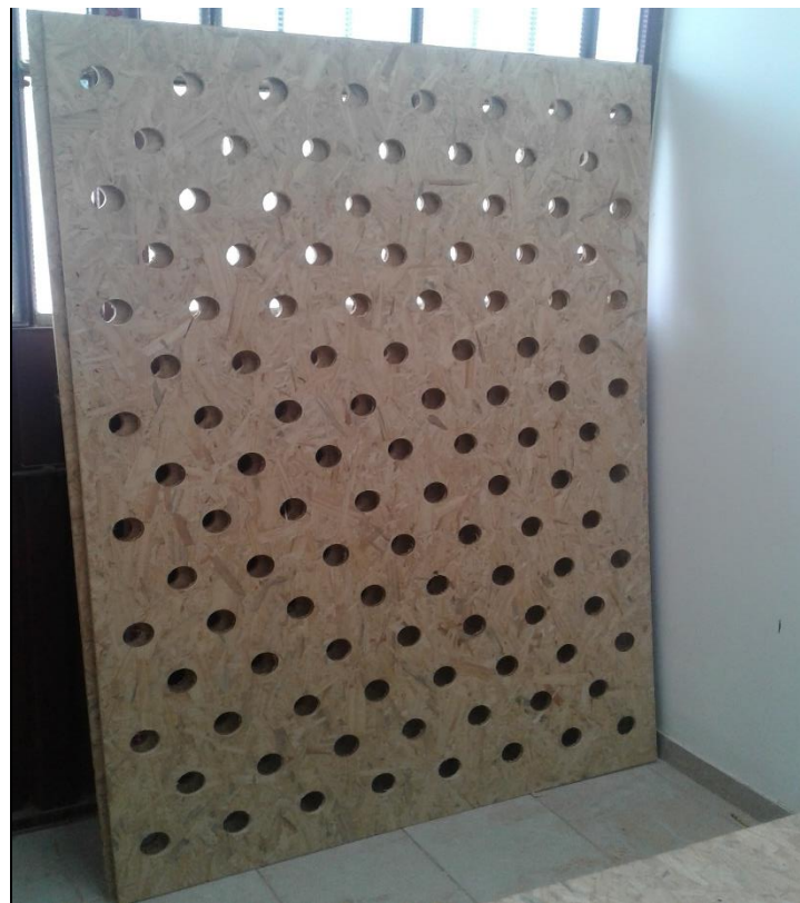
Fotografía 2.- Orificios en la plancha OSB
