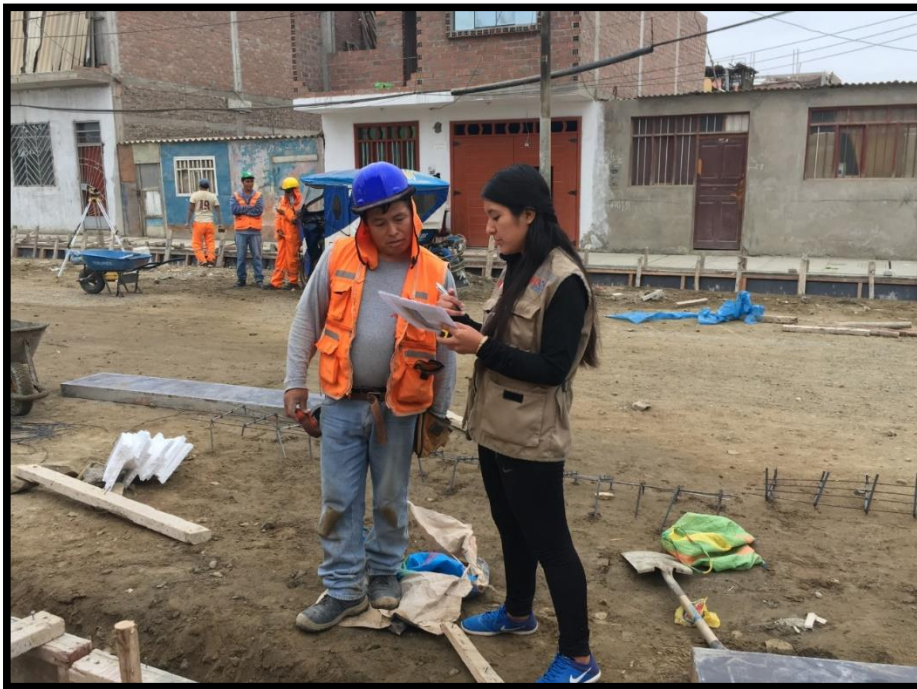
FIG 4: Realizando encuesta a operador de maquinaria - Corte hasta nivel de la Subrasante
