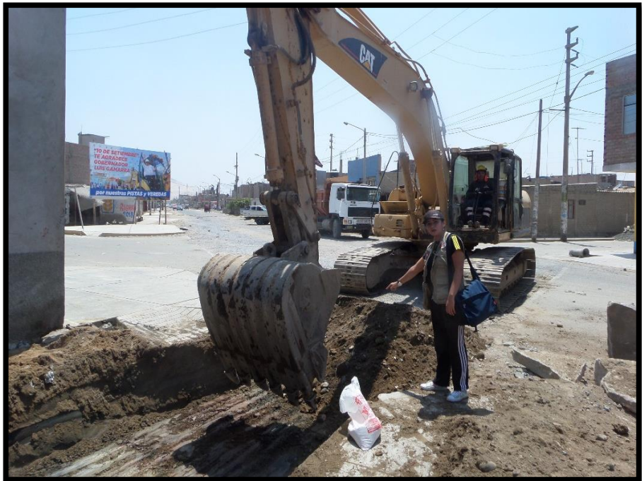
FIG 5: Corte hasta nivel de la subrasante
