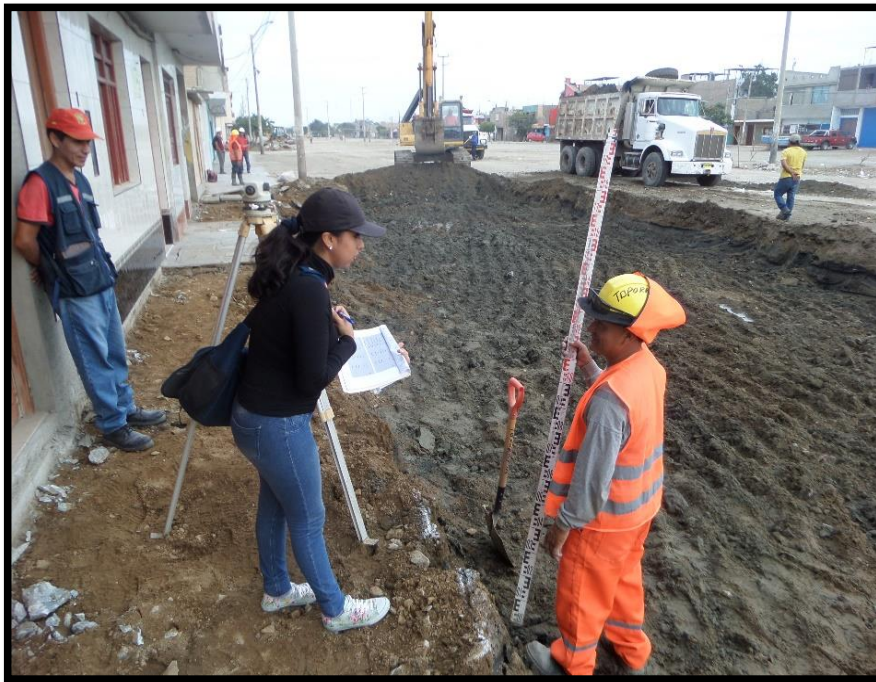
FIG 2: Realizando encuesta a los trabajadores - Corte hasta nivel de la Subrasante
