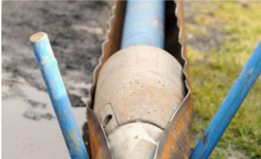
*Figura 3.* Ejemplo de ampliador de tipo cónico para la rotura de tuberías, mientras se coloca al mismo tiempo la nueva.
