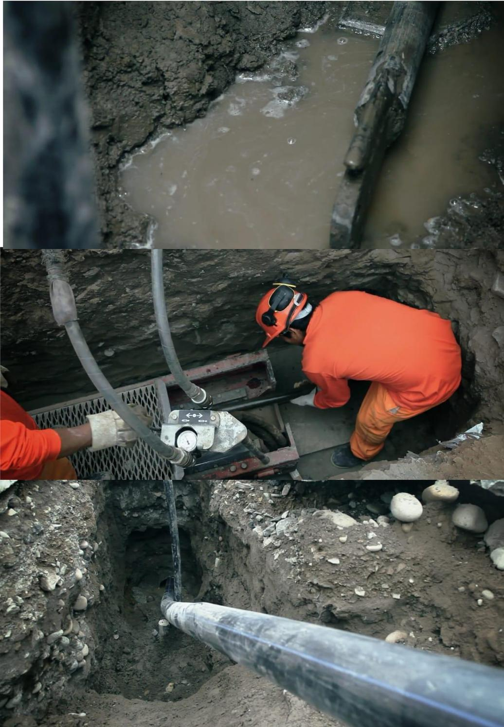
*Figura 24.* Colocación de los equipos y luego se coloca el cono de acero o flecha.
