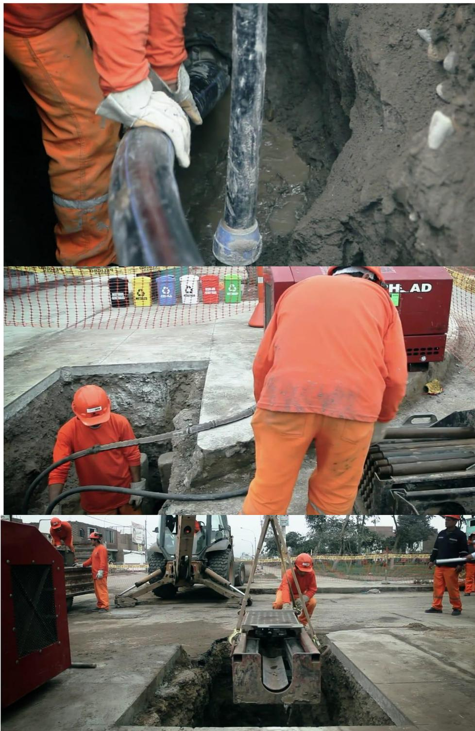
*Figura 25. Colocación del tubo polietileno termo funcionado que se da colocado al cono de acero.*
