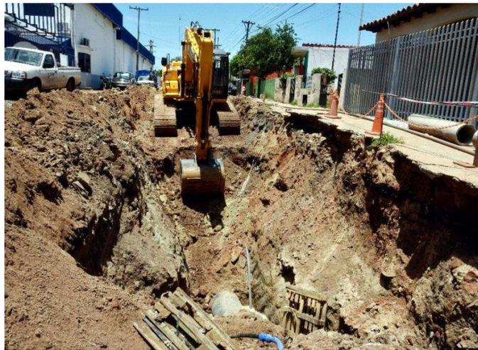
*Figura 10.* Sistema con zanja – Método Convencional
