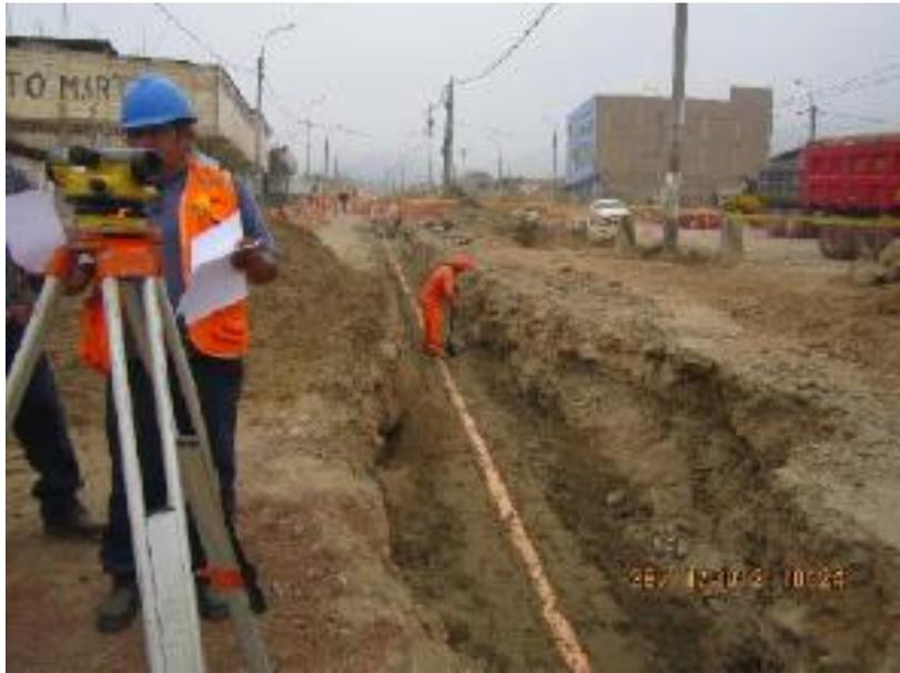
*Figura 16. Nivelación de tuberías a zanja abierta.*
