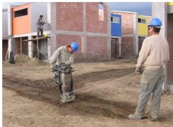
*Figura 18.* Compactación de la segunda capa de relleno.
