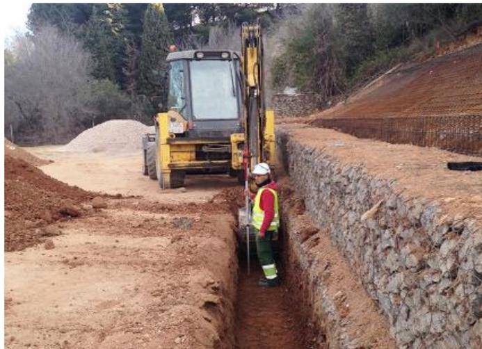
*Figura 12.* Colocación de cama de apoyo para tuberías.
