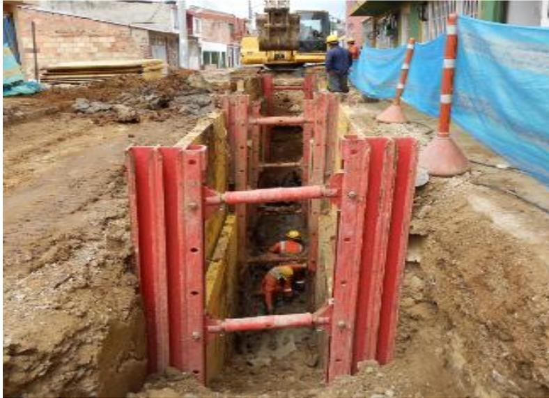
*Figura 14.*Entibada metálica de excavación
