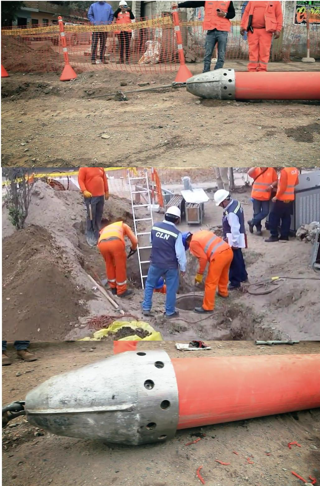
*Figura 26.* Se procede a regresar las barras para que esta manera se introduzca el tubo y reemplace la vieja tubería.
