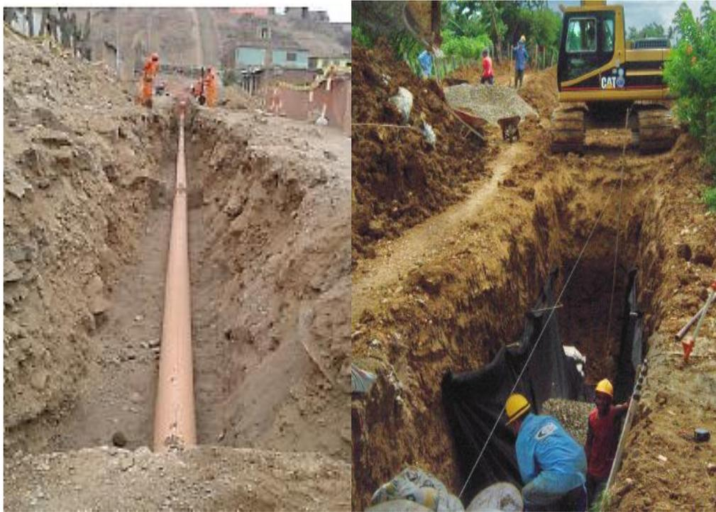
*Figura 15.* Instalación de tuberías de alcantarillado.
