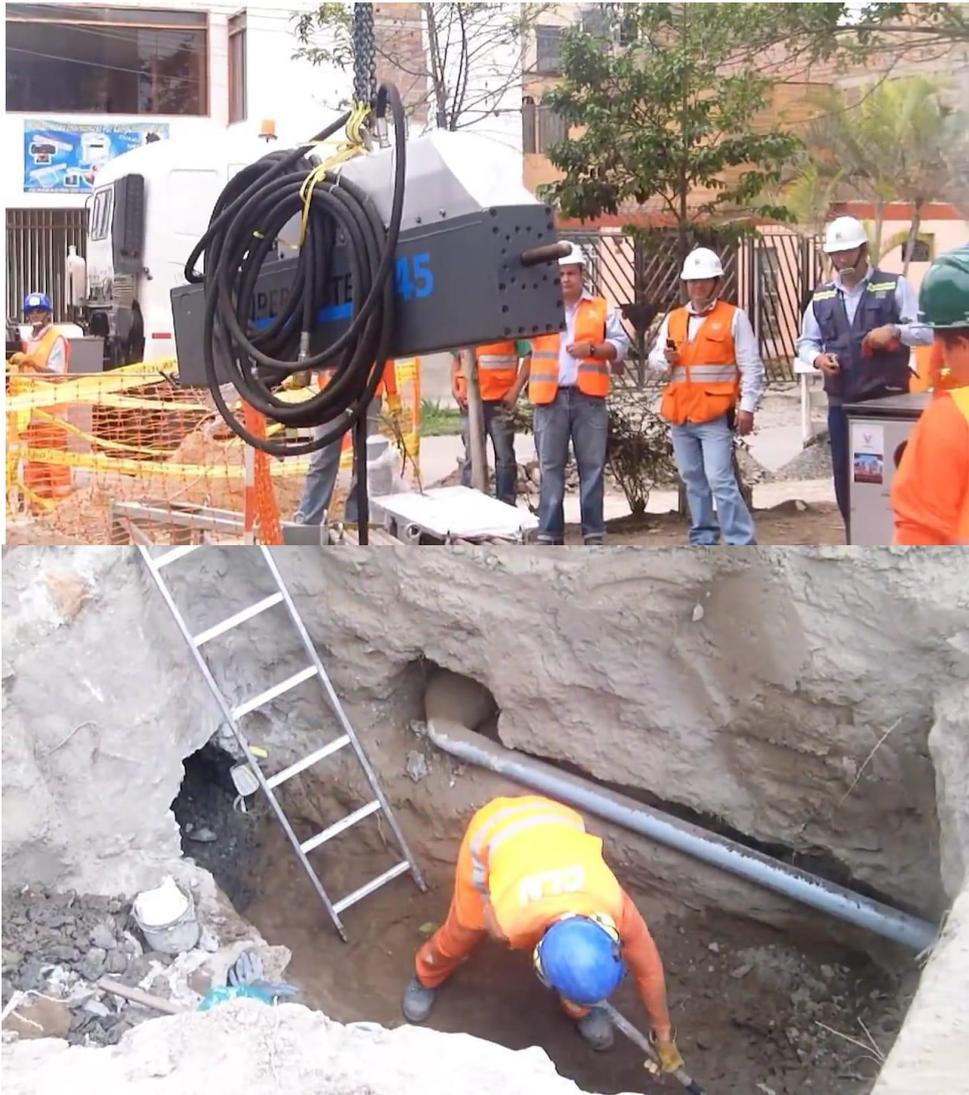
*Figura 27.*Una vez instalado el tubo general y las tomas domiciliarias se procede a la compactación del concreto y asfalto.
