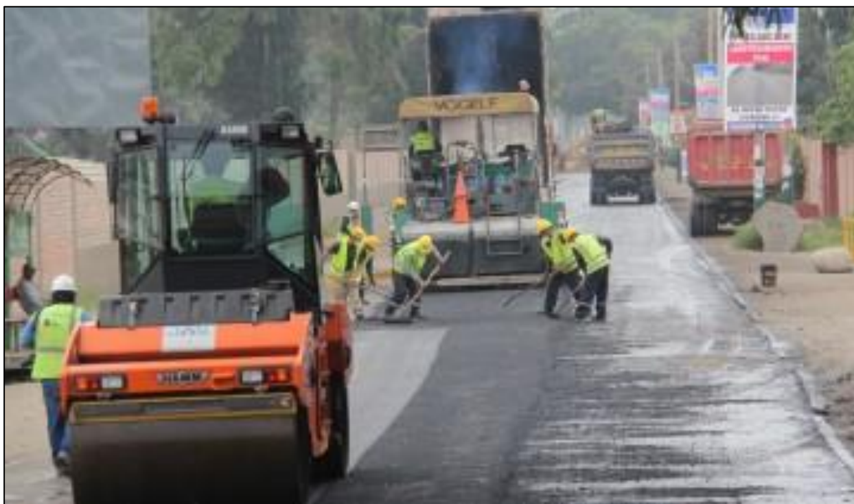
Ilustración 18. Proceso de mantenimiento de una mezcla asfáltica
