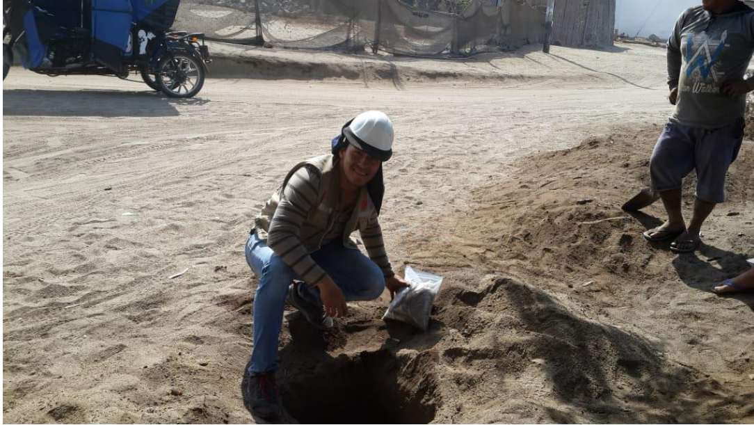
Extracción de materiales para el posterior estudio de mecánica de suelos km - 04
