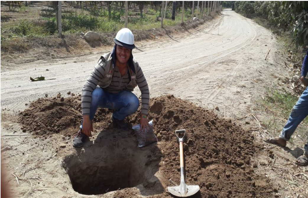
Extracción de materiales para el posterior estudio de mecánica de suelos km - 06
