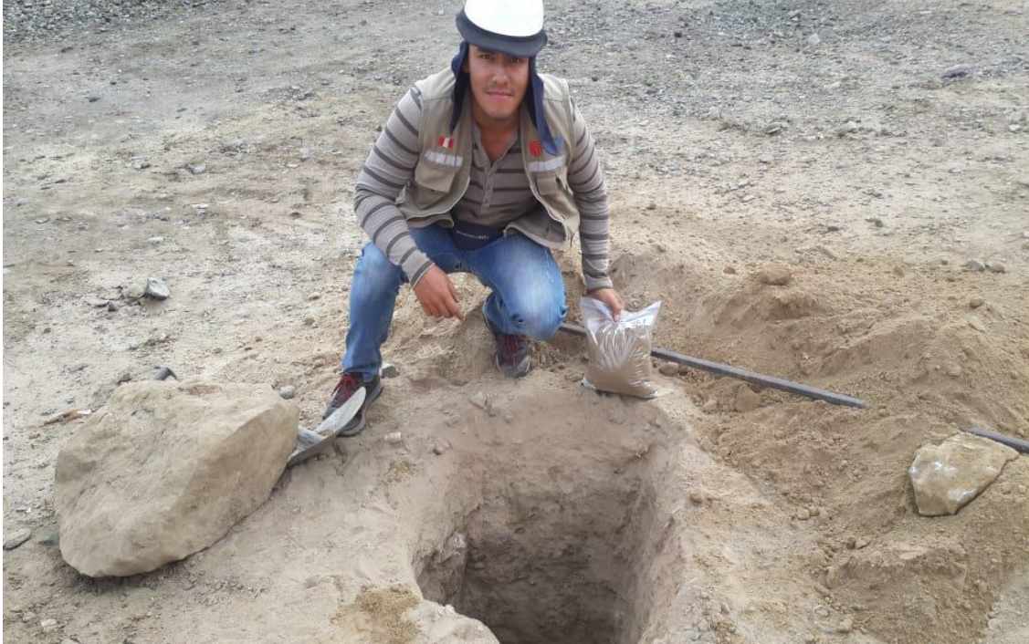
Extracción de materiales para el posterior estudio de mecánica de suelos km - 01
