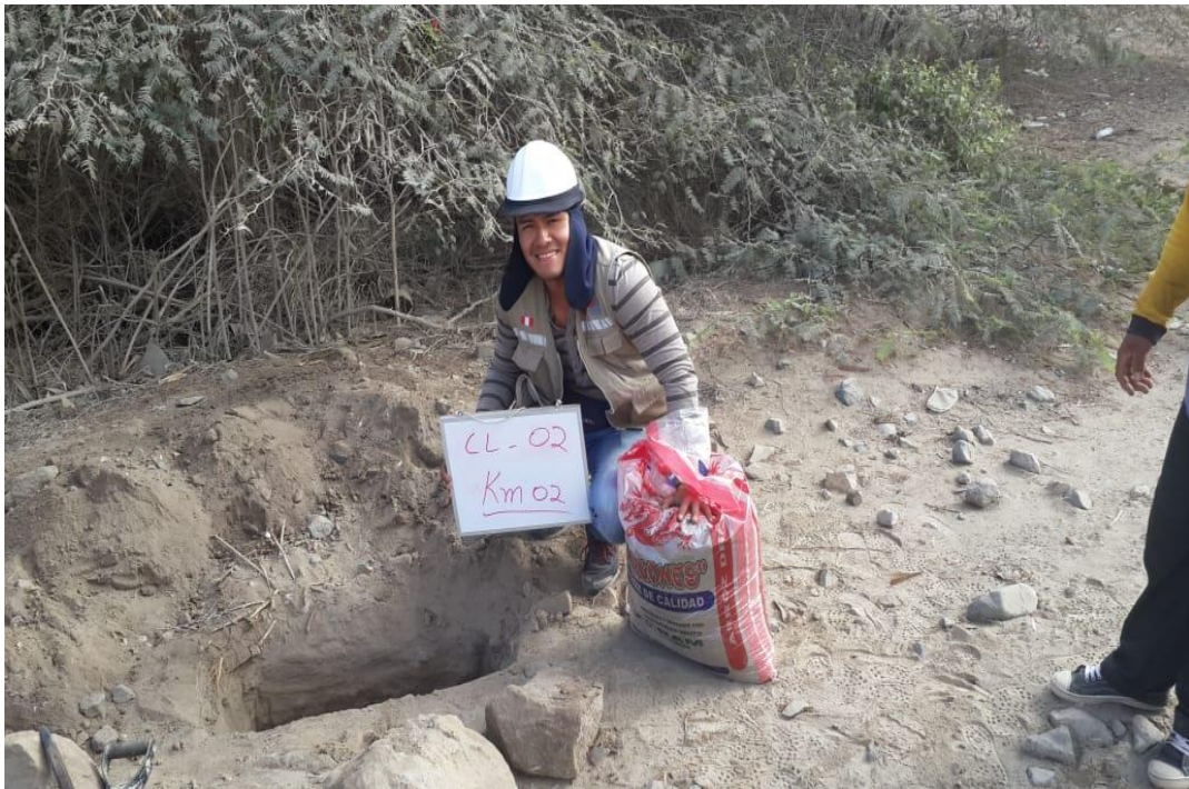
Extracción de materiales para el posterior estudio de mecánica de suelos km - 02
