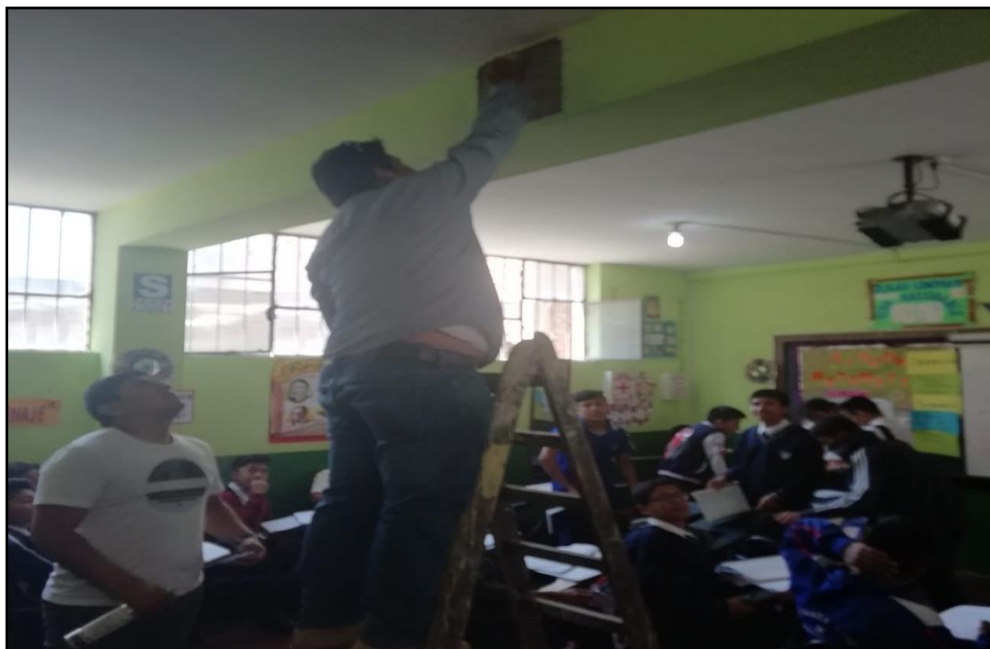
Figura 11. . I.E “Santa lucía”, Delimitación de Puntos para el ensayo, Módulo 2, 2018
