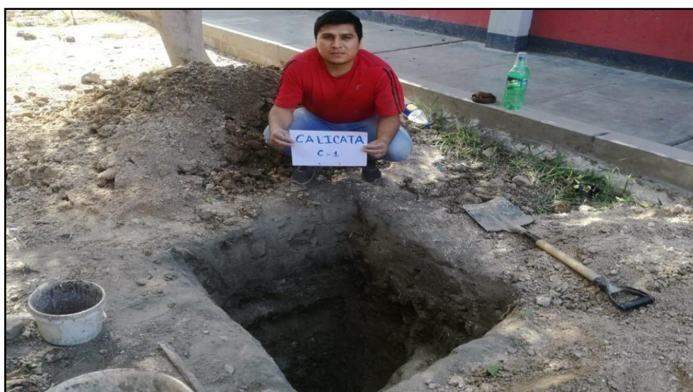
Figura 1 . I.E “Santa lucía”, Excavación de la calicata N° 01, 2018
