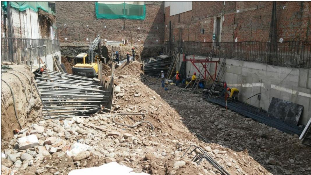
Fotografía 02: Obras de Concreto Armado - Encofrado de muros pantalla
