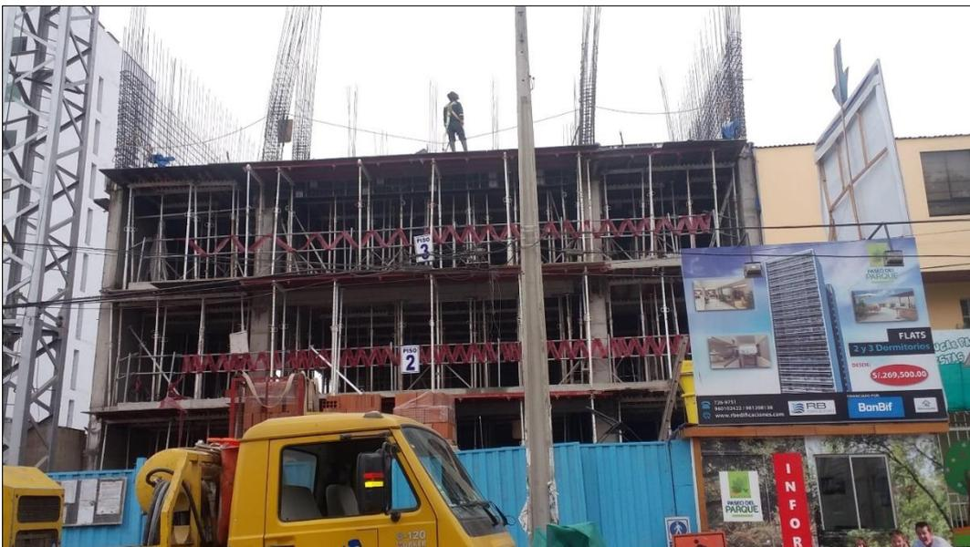
Fotografía 06: Obras de Concreto Armado – Colocación de ladrillo para losa
