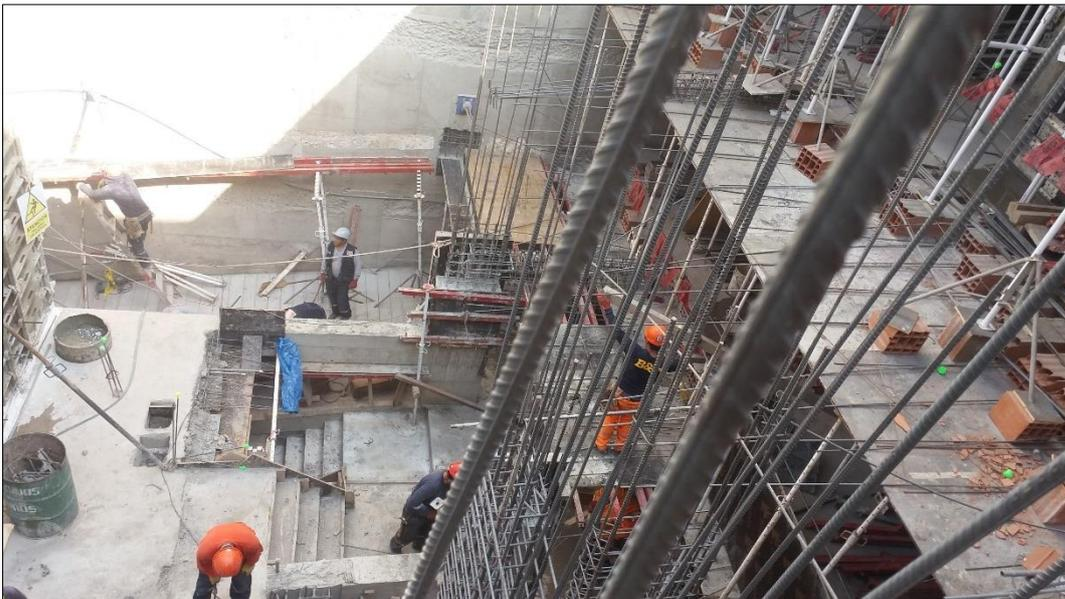
Fotografía 04: Obras de Concreto Armado – Encofrado de Losa
