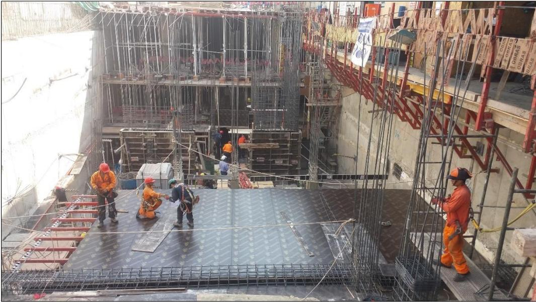
Fotografía 03: Obras de Concreto Armado – Encofrado de Losa
