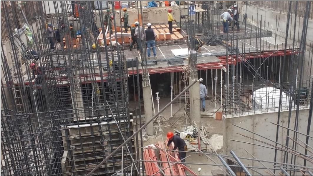
Fotografía 07: Obras de Concreto Armado – Colocación de ladrillo para losa
