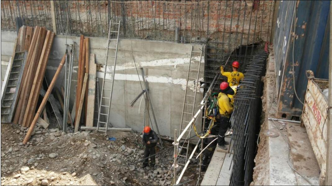
Fotografía 01: Obras de Concreto Armado - Ejecución de muros
