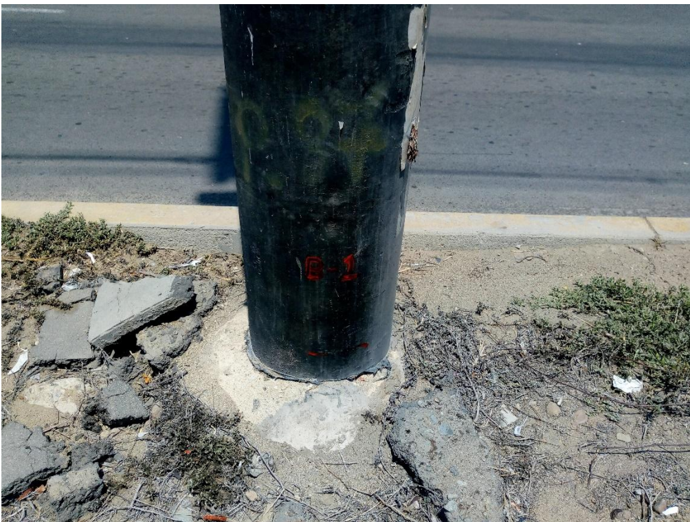
Figura 6 Punto referencial de inicio - Toma de Agua
