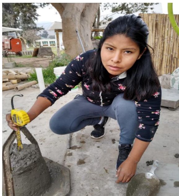
Prueba de revenimiento
