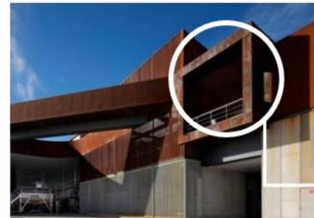
Como no requiere una protección especial contra la corrosión como la mayoría de los otros metales, la necesidad de mantenimiento se reduce drásticamente y se eliminan los procesos altamente contaminantes de la galvanización y la aplicación de pinturas protectoras..
