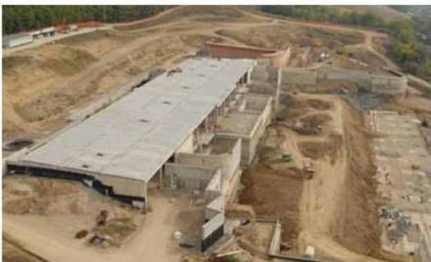
El sistema constructivo del proyecto se basa en la excavación de casi 15ha de cultivos para construir el edificio para posteriormente cubrirlo con la tierra extraída y como resultado obtuvieron que la cubierta forme parte del paisaje.
