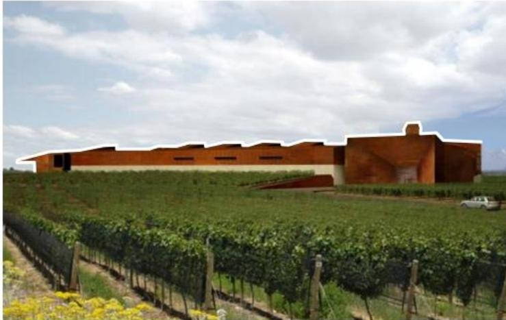
Un basamento de hormigón visto que se adapta al carácter industrial del proyecto está acompañado por una cubierta unificada en un único material: el acero Corten. Por su textura y color, el acero mantiene un diálogo cromático con el entorno y cumple el objetivo de reducir al mínimo el impacto ambiental de la planta.
