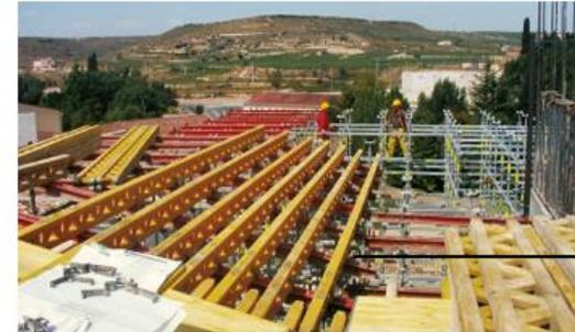
El VARIO GT 24 es el sistema de encofrado para muros o losas con ajuste continuo. Tanto en edificios industriales como de viviendas, estribos de puentes o muros de contención, con esta técnica se puede encofrar cualquier planta y altura hasta 18 m en un solo panel.
