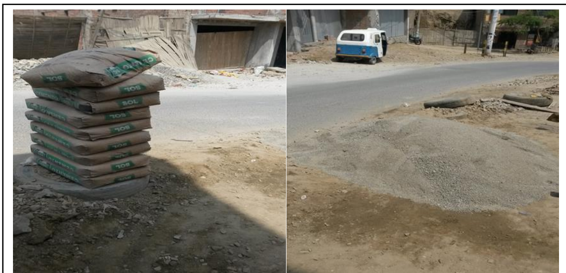
Figura 175. Materiales cemento sol y arena gruesa. Fuente: Elaboración propia.
