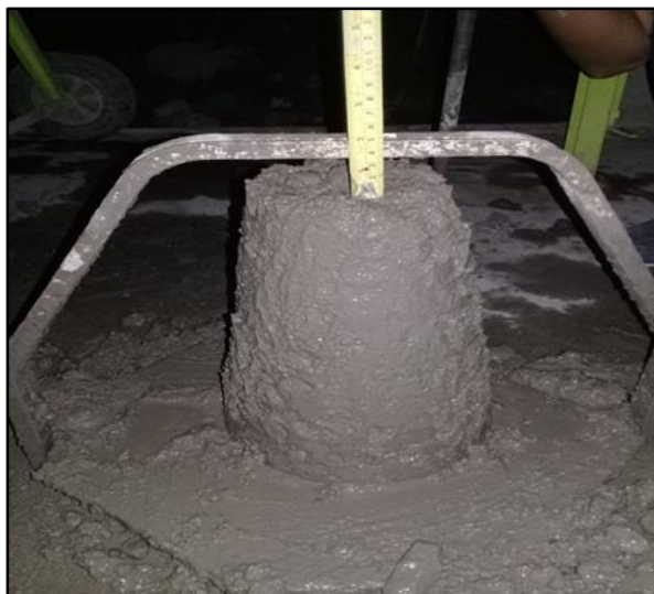
Figura 122. Verificación del slump requerida. Fuente: Elaboración propia.
