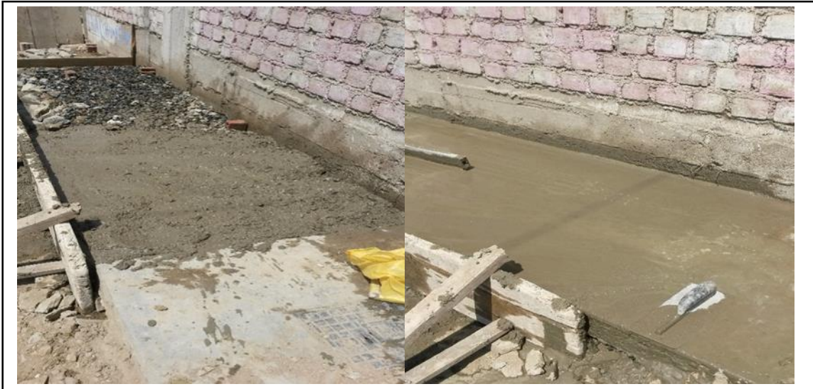
Figura 182. Vertimiento del concreto y nivelando superficialmente. Fuente: Elaboración propia.
