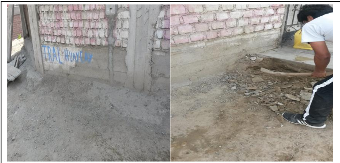
Figura 177. Limpieza del terreno natural. Fuente: Elaboración propia.
