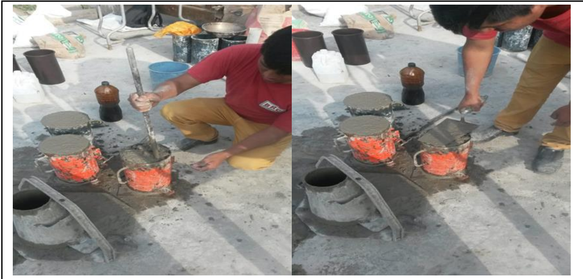
Figura 117. Mezcla vertida en los moldes de las probetas. Fuente: Elaboración propia.
