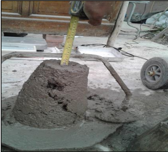
Figura 114. Verificación del slump. Fuente: Elaboración propia.
