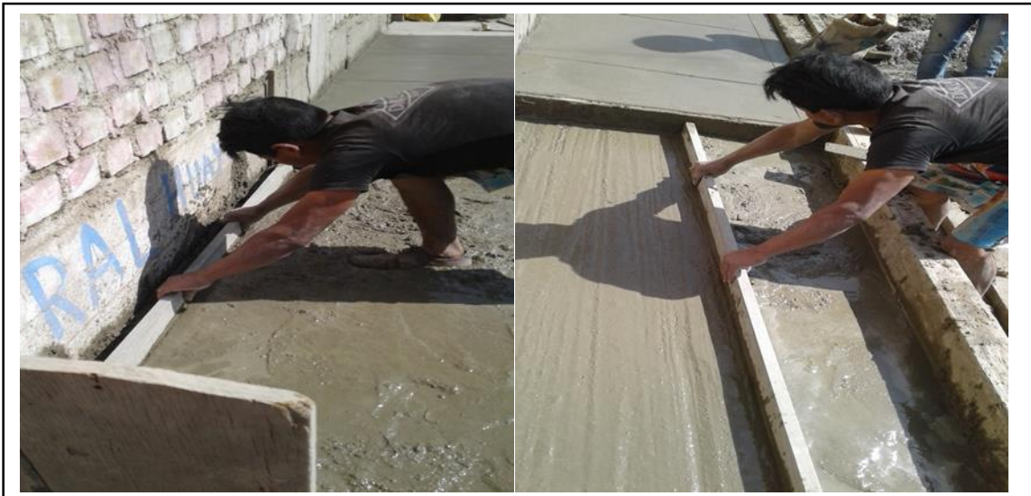
Figura 189. Nivelación de la vereda. Fuente: Elaboración propia.
