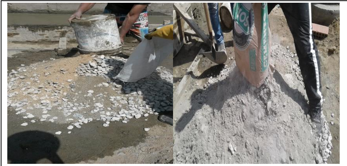
Figura 185. Agregando arena, agregado grueso reciclado y cemento. Fuente: Elaboración propia.
