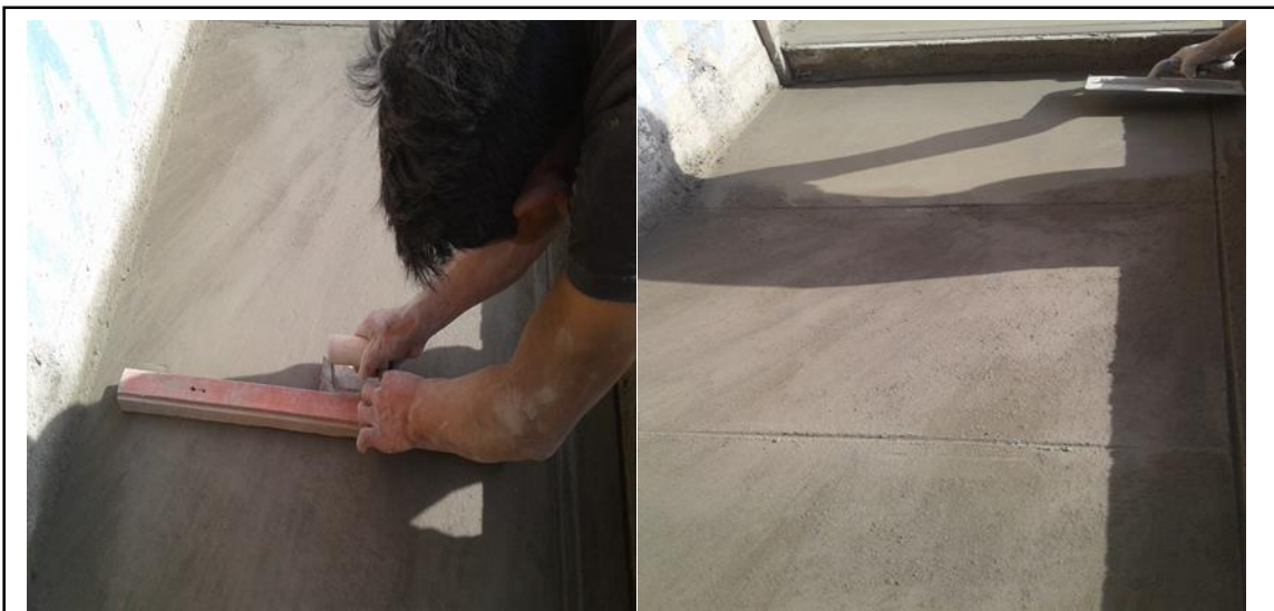
Figura 190. Realización de la bruñas. Fuente: Elaboración propia.
