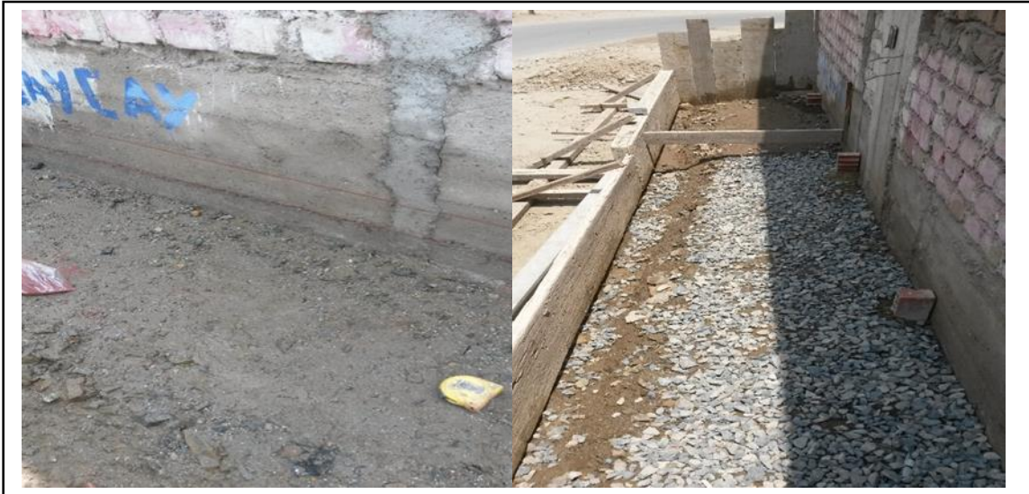
Figura 180. Terreno saturado y cama con piedra chancada. Fuente: Elaboración propia.
