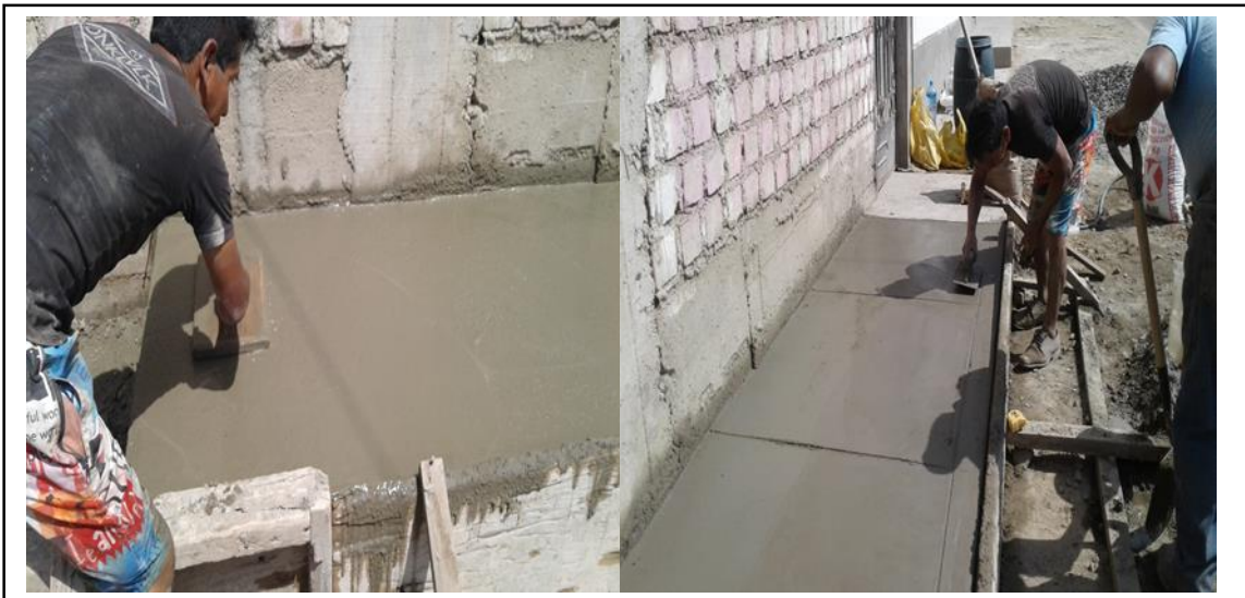
Figura 184. Acabado de las bruñas. Fuente: Elaboración propia.
