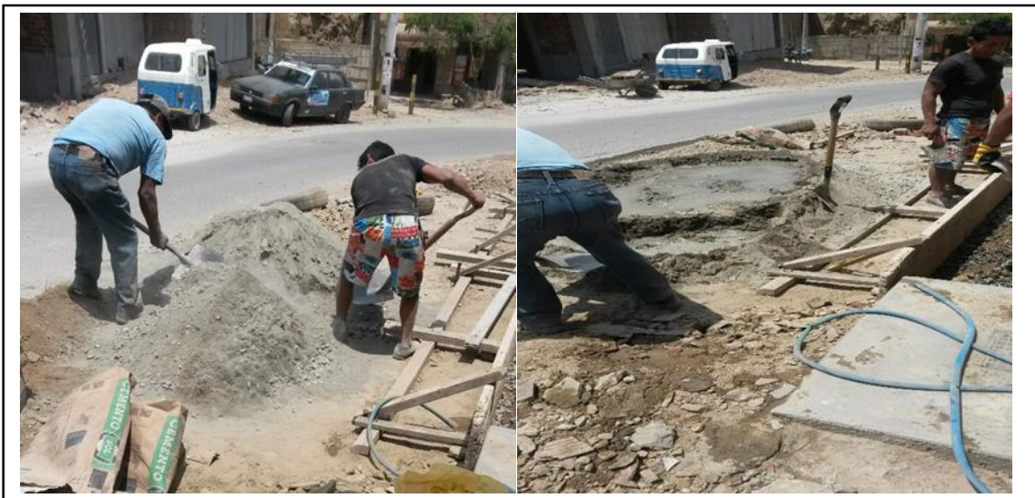
Figura 181. Mezclado de concreto. Fuente: Elaboración propia.
