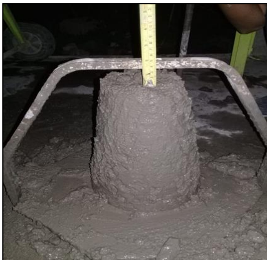
Figura 135. Verificación del Slump requerida. Fuente: Elaboración propia.
