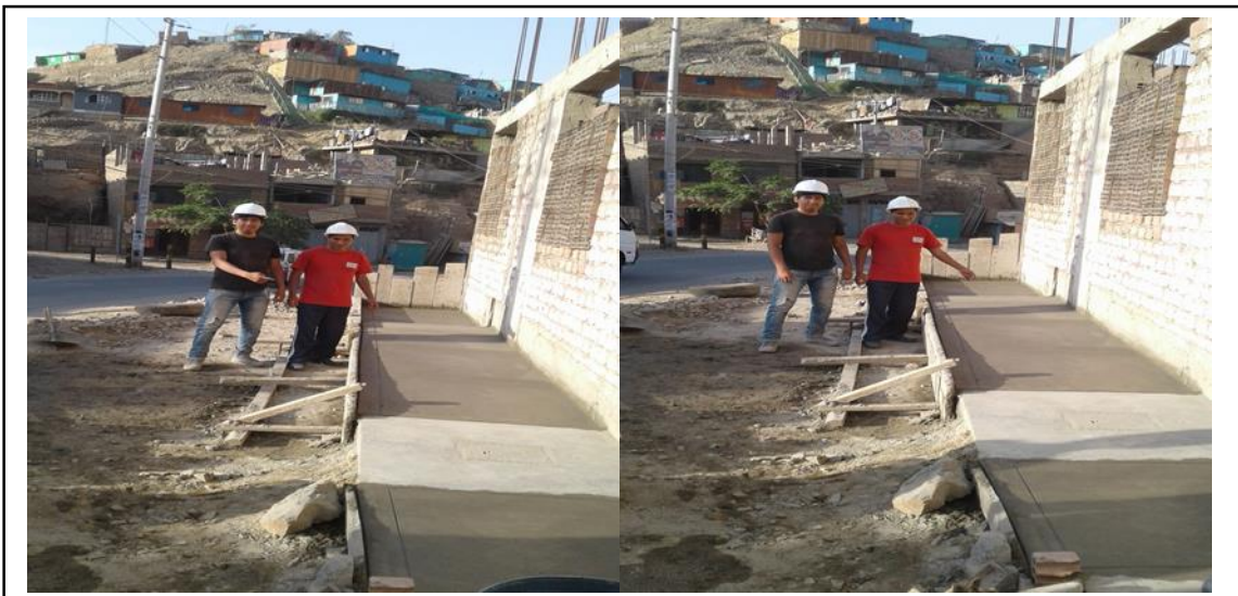
Figura 193. Finalización del acabado de la vereda. Fuente: Elaboración propia.
