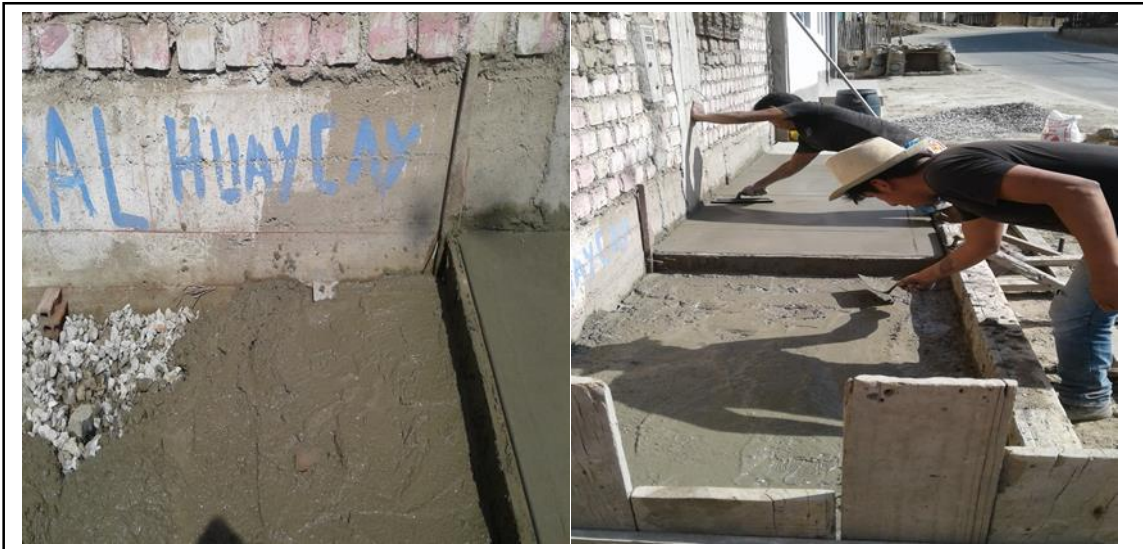
Figura 188. Vertimiento del concreto a la vereda. Fuente: Elaboración propia.
