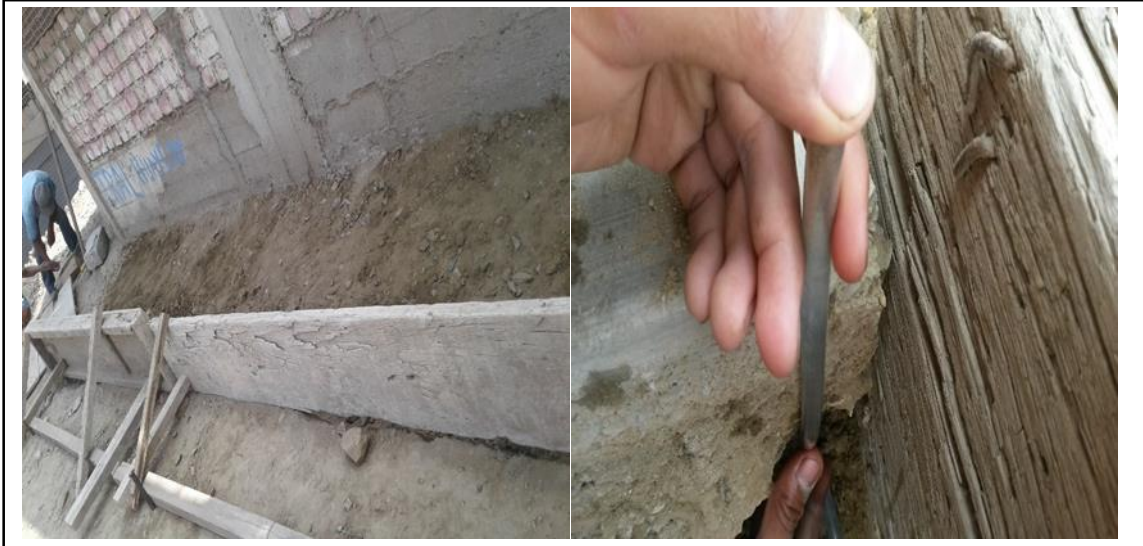
Figura 179. Compactando el terreno y nivelando con la manguera de agua. Fuente: Elaboración propia.
