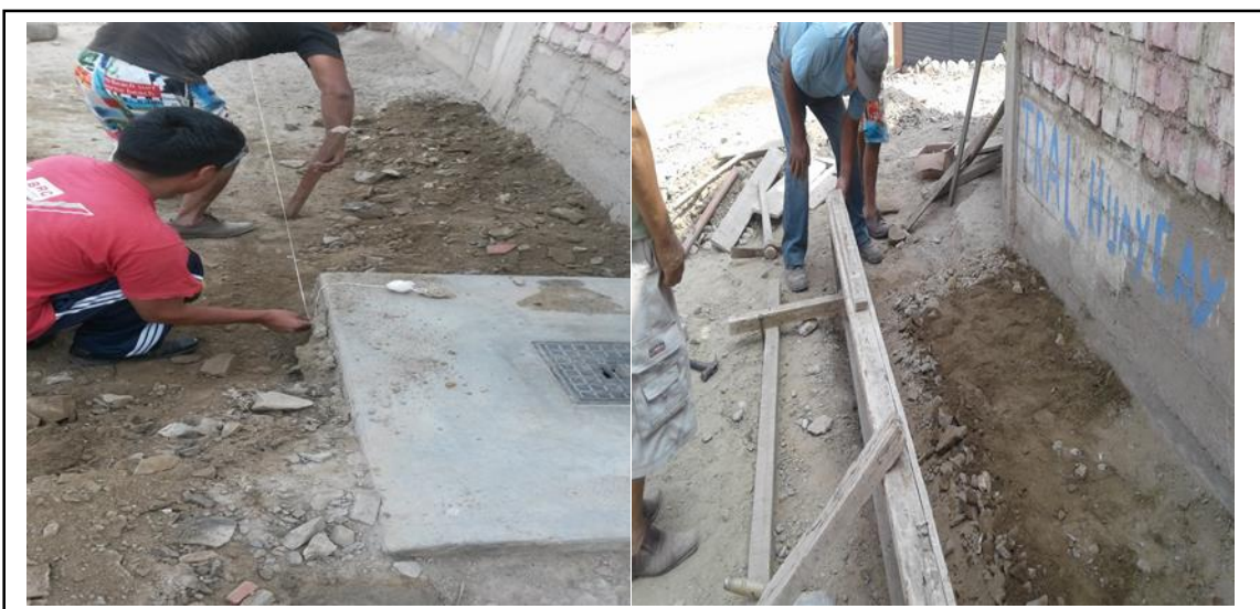
Figura 178. Trazo en el terreno y encofrado de la vereda. Fuente: Elaboración propia.
