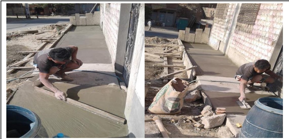
Figura 192. Nivelación y acabado del tramo pequeño. Fuente: Elaboración propia.
