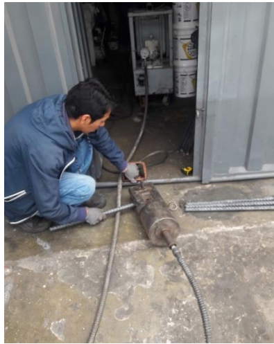
Prensado final para el conector de presión y de presión con rosca tipo 2
