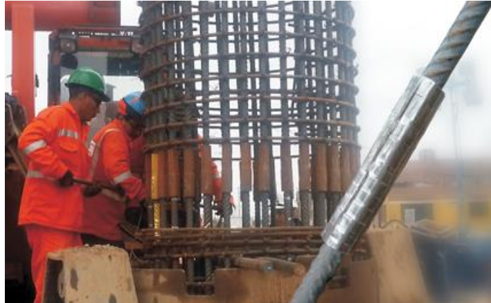
Figura 1. Conector de presión tipo2 (Bargrip)
