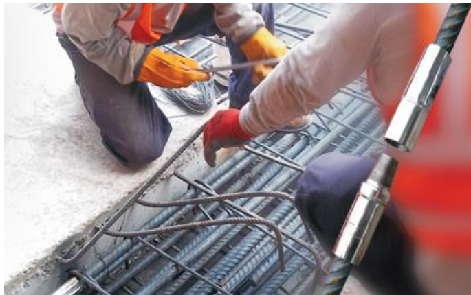
Figura 2. Conector de presión con rosca tipo 2 (Griptwist)
