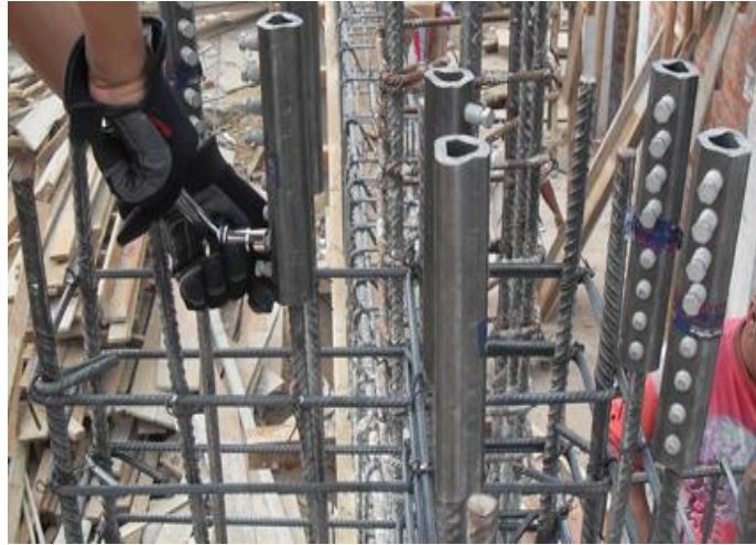
Figura 3. Conector de tornillo (Zap screwlok)
