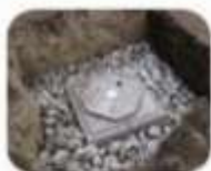
Vertical tipo pozo de absorción.
