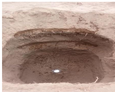
Figura 13: Calicata terminada.
