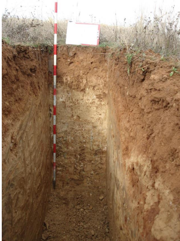
Figura 12. Vista de C – 01, En el camino vecinal ccayao- Luricocha. Elaboración propia.
