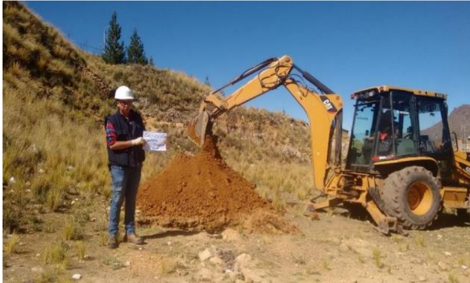
Figura 11. Elección del tramo de intervención camino vecinal Ccayao. Elaboración propia.
