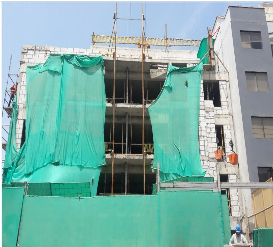
Foto 2. Etapa de ejecución de tabiquería
