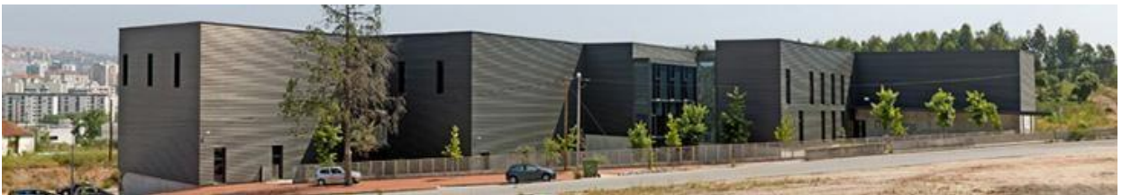
Figura 4: fachada principal de ITeCOns
