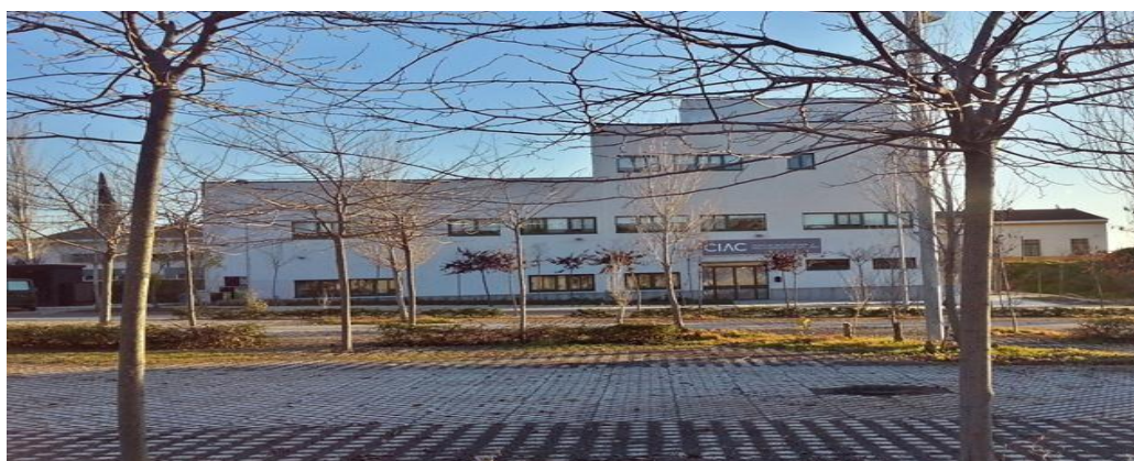
figura 6: fachada frontal de “ciac”
