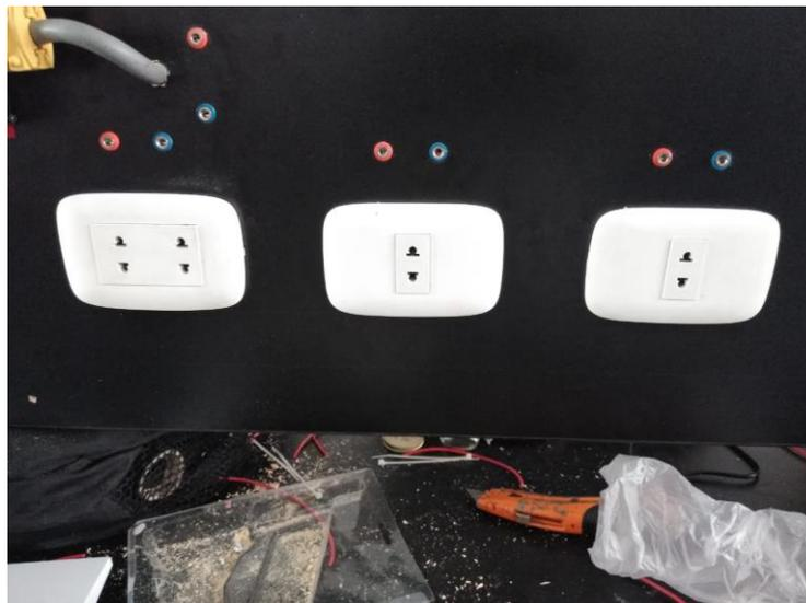
**Figura 10.- Instalación de tomacorrientes. Fuente: Propia**
