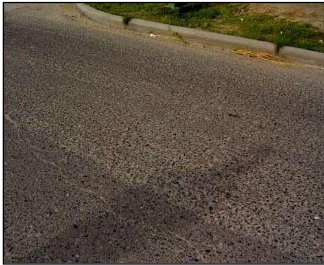
Figura 22 Peladura
