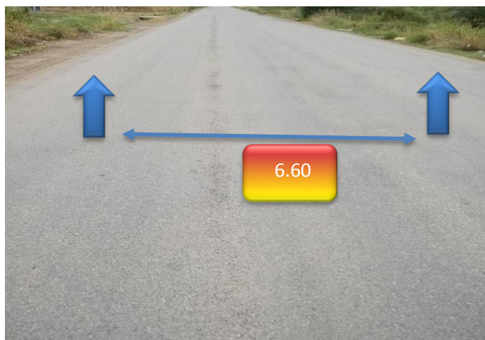
Figura 27 Ancho de Calzada carretera Bagua - Alenya
