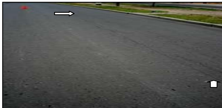
Figura 18 Ahuellamiento
