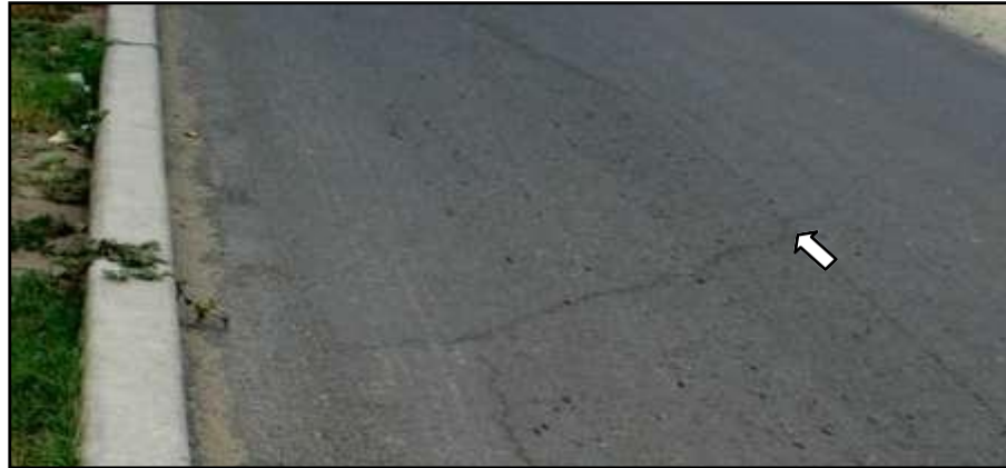
Figura 20 Fisura parabólica
