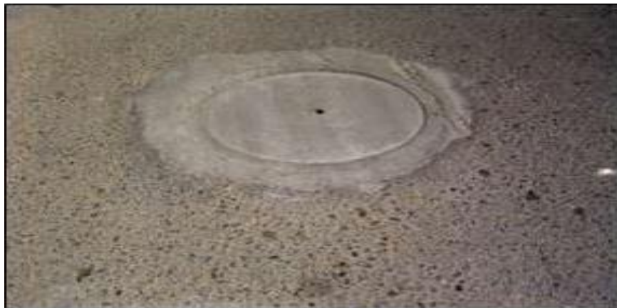
Figura 15 Parches de Cortes Utilitarios
