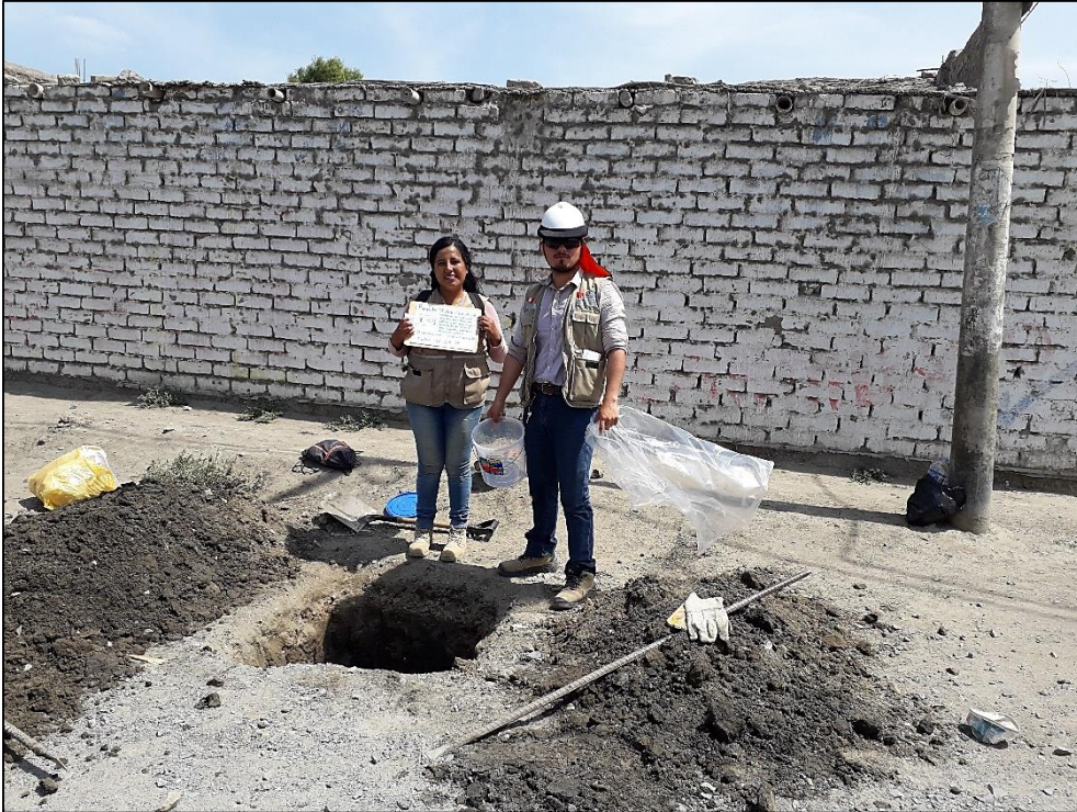
Fotografía N° 09. Los tesistas Lorena Luna Enriquez y Breiner Yzaguirre Caballero realizando la calicata N° 01 para la obtención de muestras en la zona de estudio Red Vial Vecinal AN – 873.
