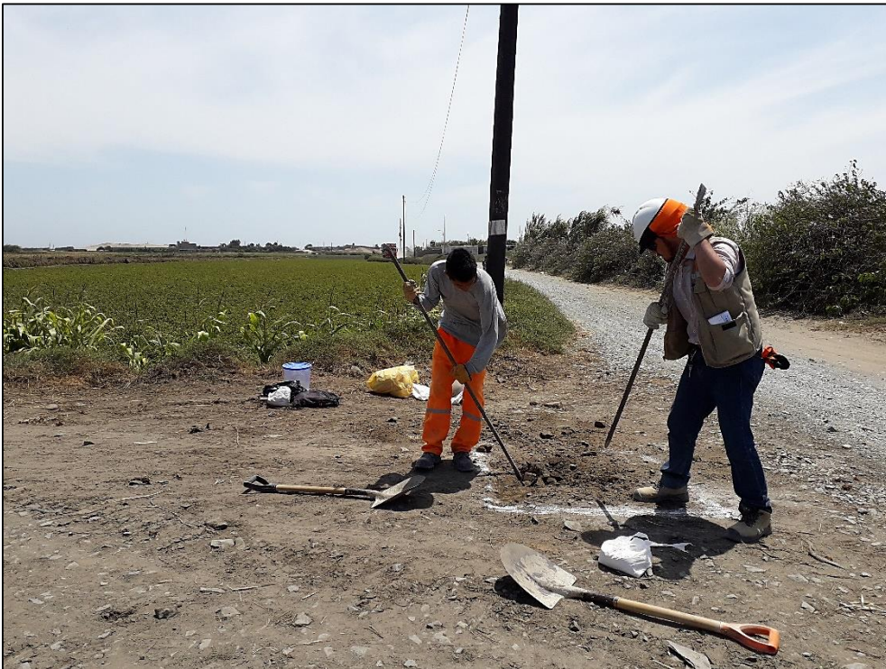
Fotografía N° 10. El tesista Breiner Yzaguirre Caballero realizando la calicata N° 02 para la obtención de muestras en la zona de estudio Red Vial Vecinal AN – 873.
