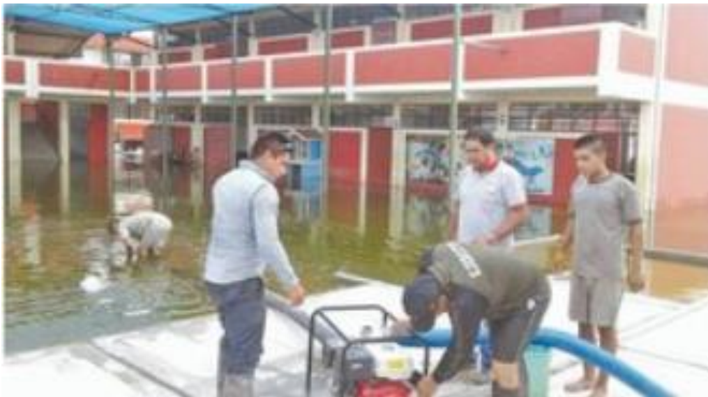
8. Descolmatación de agua en Infraestructura educativa
