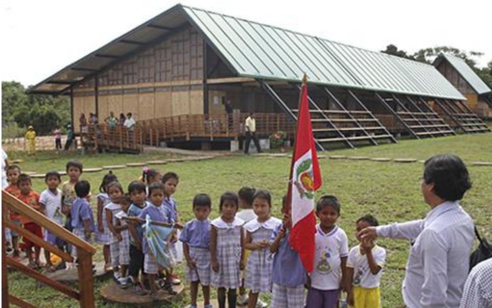
Figura N°11: La infraestructura del Plan Selva soportan la lluvia y las inundaciones, y tienen ventilación natural, que reduce la sensación de calor.
