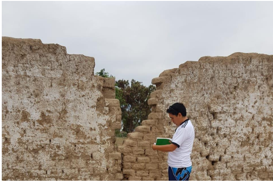
11. Evaluación de Infraestructura educativa (Chongoyape)
