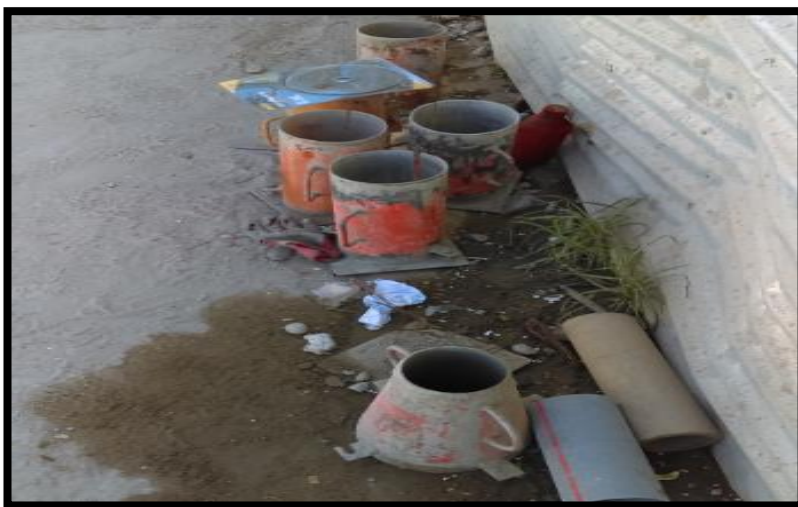
FOTOS N° 4: Representa la identificación de materiales y herramientas utilizados en obra
