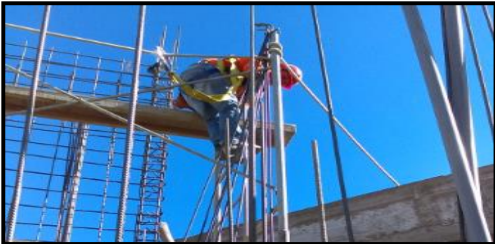
FOTO N° 17: Representa algunos trabajos en altura y el uso adecuado del arnés, línea de vida que utiliza el trabajador ya sea utilizando andamios y otros equipos de ayuda.
