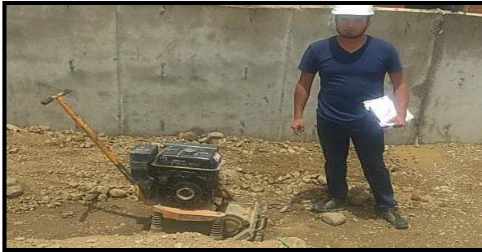
FOTOS N° 12: Inspección del trabajo seguro, utilización correcta de EPP, en la construcción del muro pantalla.
