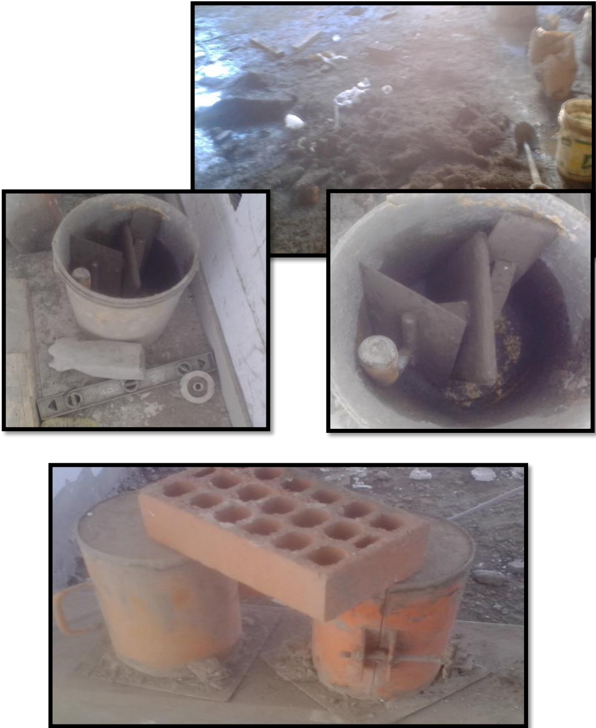
FOTOS N° 5: Representa la identificación de algunos peligros en el área de la obra en mención.
