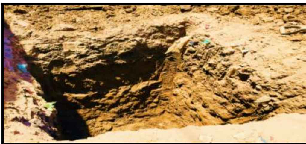
Figura 1: Excavación de la calicata N°1 del lote N°12 de la av.San Antonio Jlo
