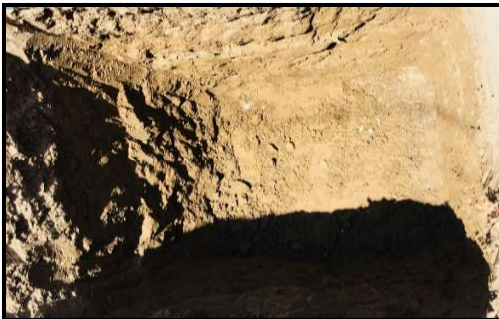
Figura 2: Excavación de la calicata N°2 del lote N°12 de la av.San Antonio Jlo
