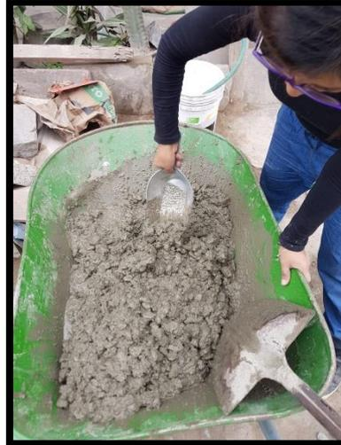
3.- Se añade finalmente agua y se procede a realizar la mezcla de manera manual.
