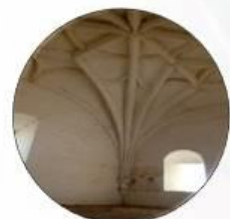
Bóvedas de crucería
