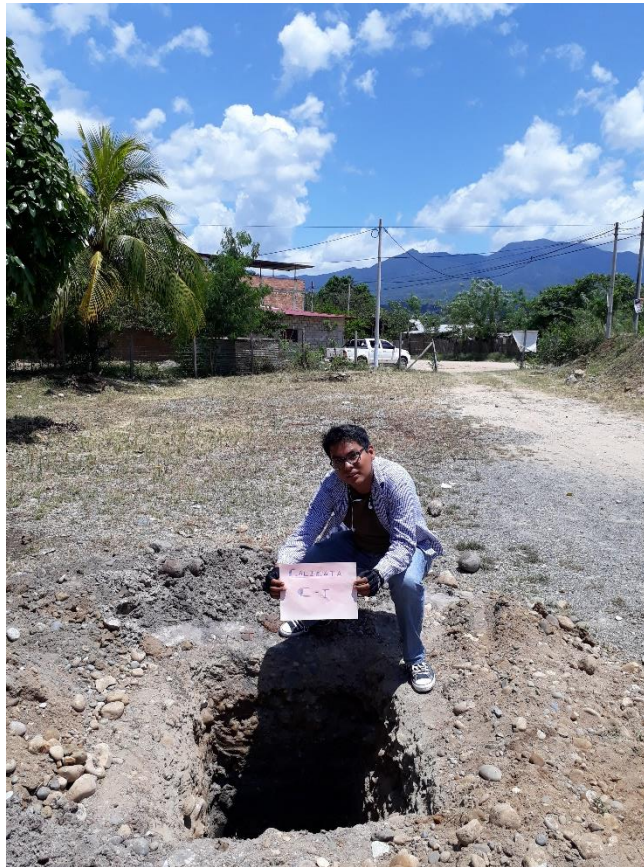
Figura 7. Excavación de calicata
