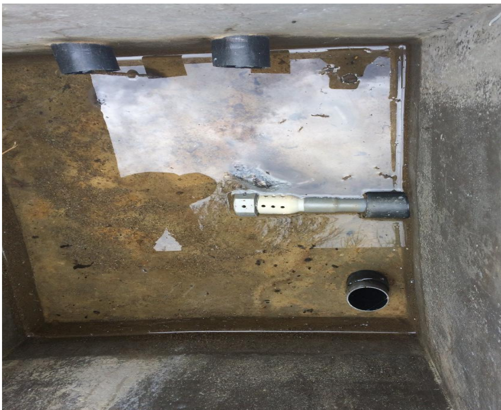
Anexo 43: Fotografía del Interior de la tercera captación.
