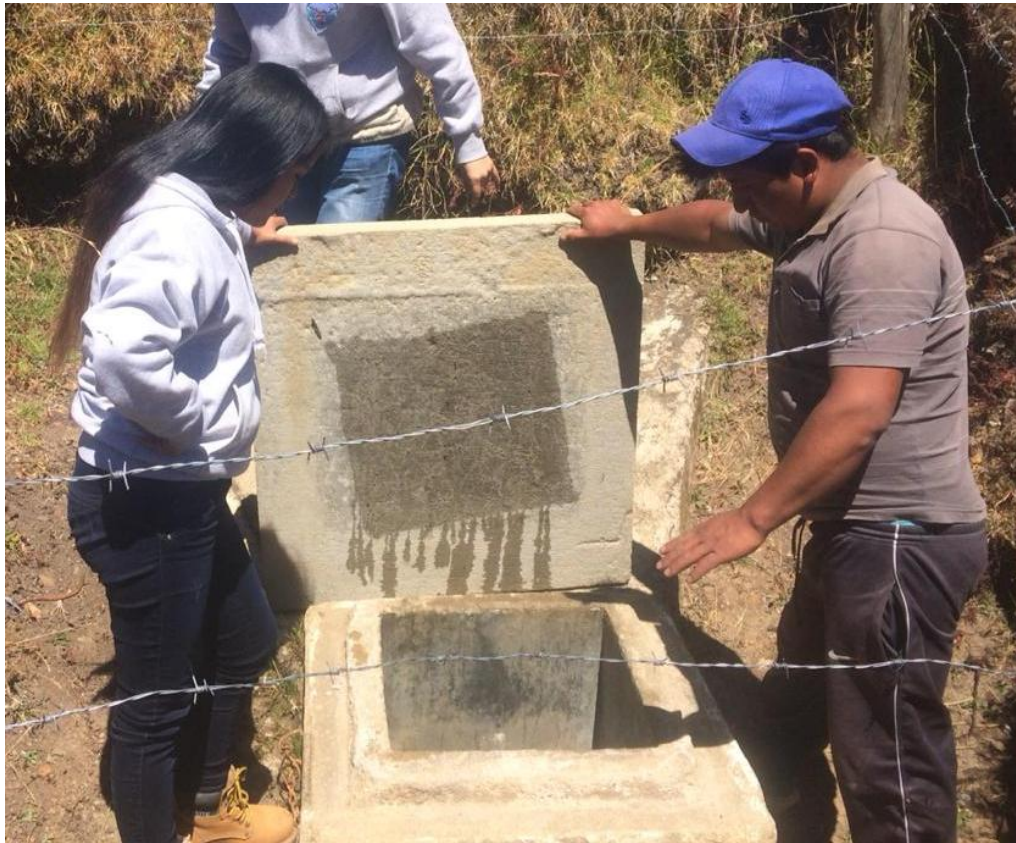
Anexo 40: Fotografía retirando la tapa sanitaria de la tercera captación.
