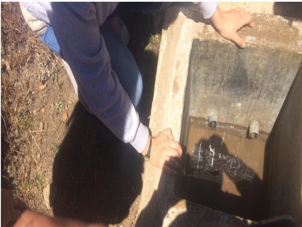
Anexo 42: Fotografía del interior de la tercera captación.
