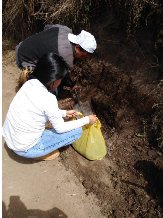
Anexo 57: Fotografía de la excavación para la segunda calicata, en la línea de conducción.
