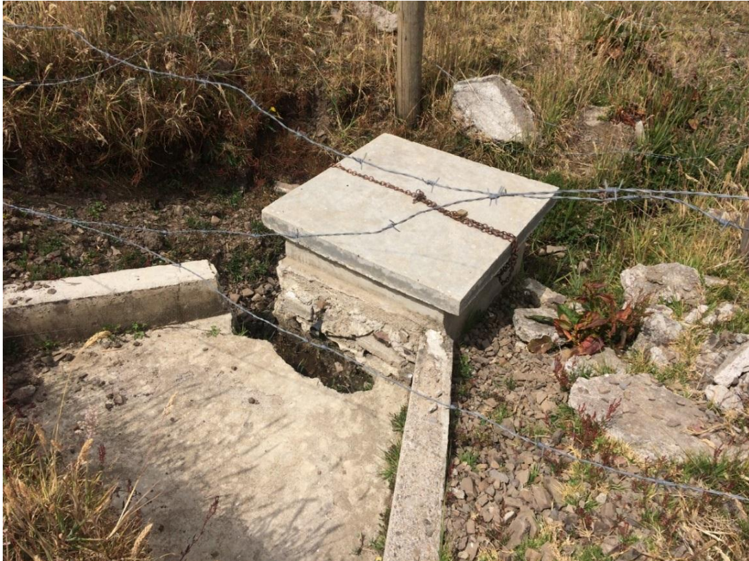
Anexo 36: Fotografía de Primera Captación.
