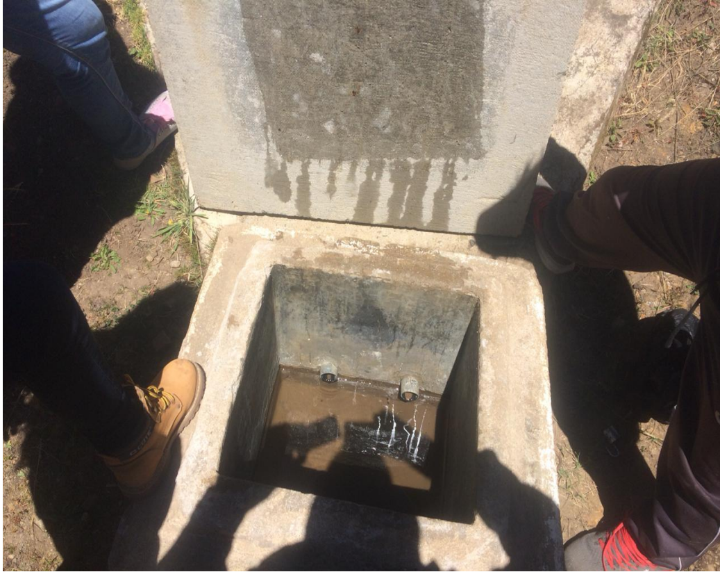
Anexo 41: Fotografía del interior de la tercera captación.
