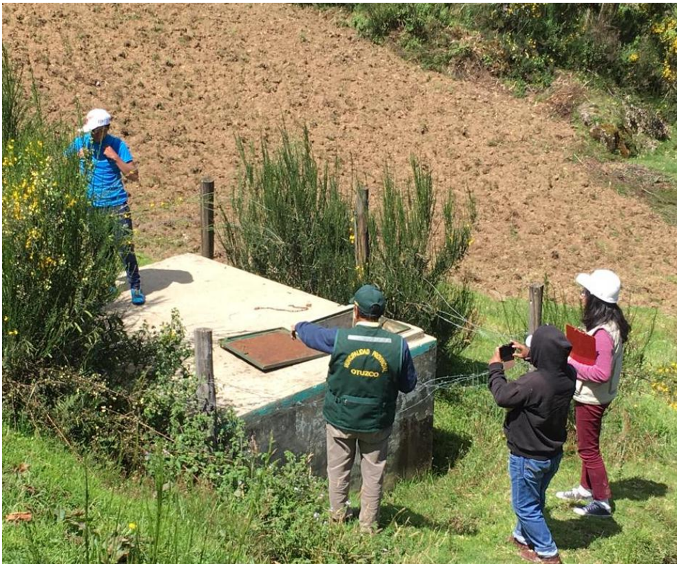
Anexo 54: Fotografía de la supervisión del estado situacional del reservorio.
