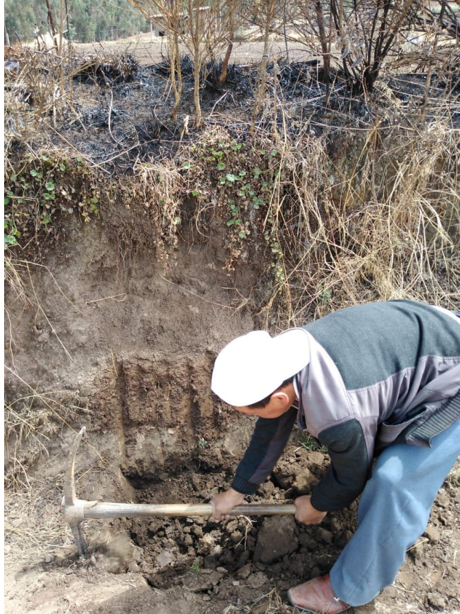
Anexo 59: Fotografía de la excavación para la tercera calicata en la zona de la línea de aducción.
