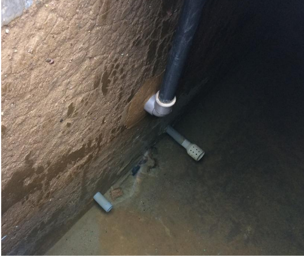
Anexo 55: Fotografía del interior del Reservorio existente.
