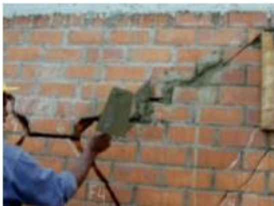
Figura 8 Picados y resanes con morteros en las fisuras gruesas
