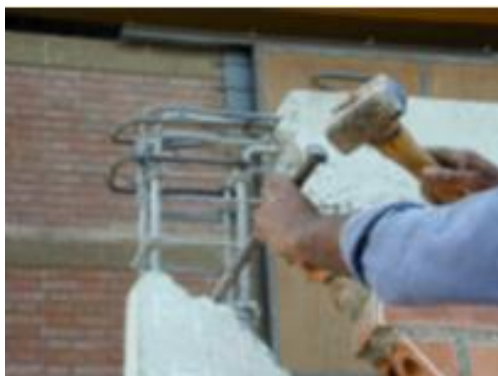
Figura 9 Picados de nudos más retiro de ladrillos rotos
