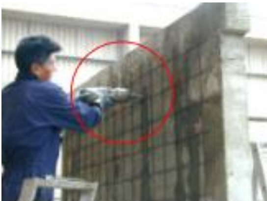
Figura 13 Tapado de perforaciones con lechada de mortero 1:3 con un inyector fuente blog.pucp.edu.pe
