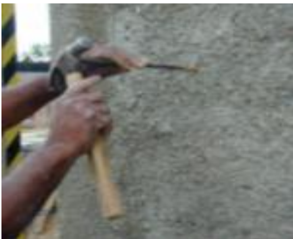
Figura 11 Perforaciones con cincel
