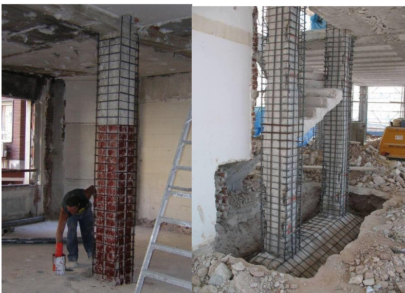
Figura 14 encamisado de columna fuente Google.com
