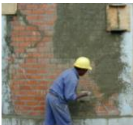
Figura 10 Pañeteo del muro
