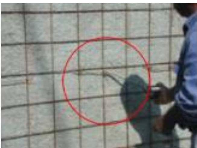
Figura 12 Amarrado de la malla con los conectores
