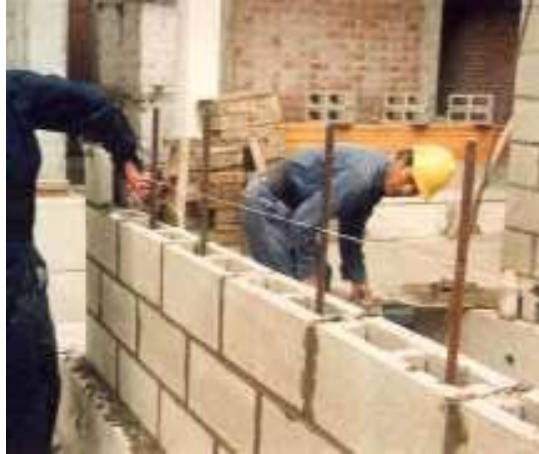
Figura 3 construcción de muro de albañilería armada
