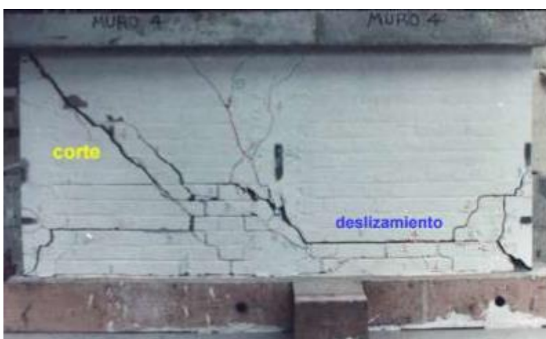
Figura 5 Fallas por corte originados por la tracción diagonal y deslizamientos en San Bartolomé - año 2015
