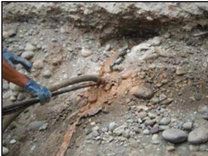
*Figura 21. Cable inyectado.*
