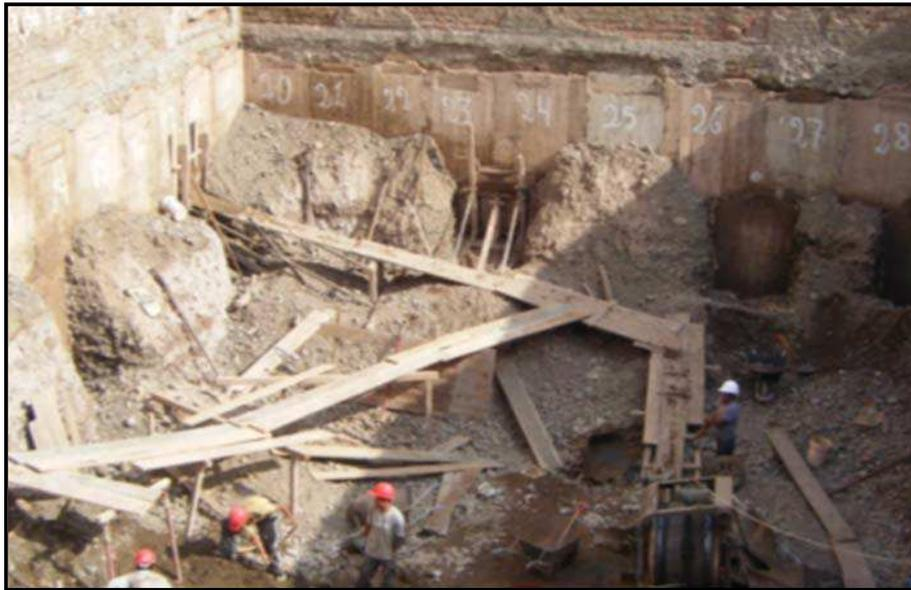
*Figura 6.* Encofrado y rampa de calzaduras.
