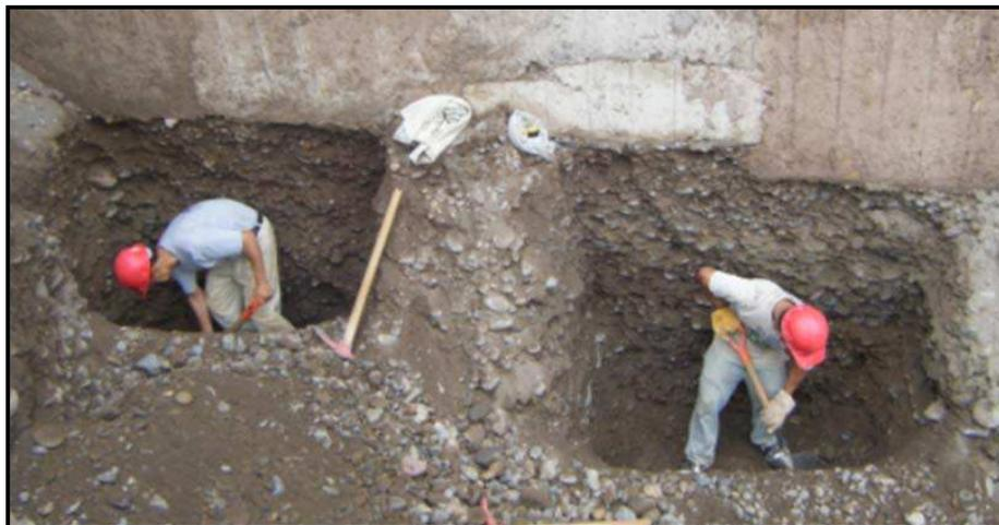
*Figura 4.* Excavación de forma alternada.
