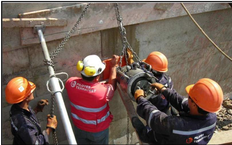
*Figura 29. Tensado de anclajes*
