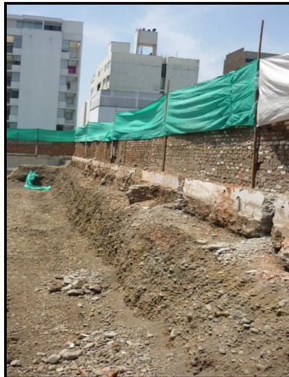
*Figura 14.* Perfilado del talud 1:3.
