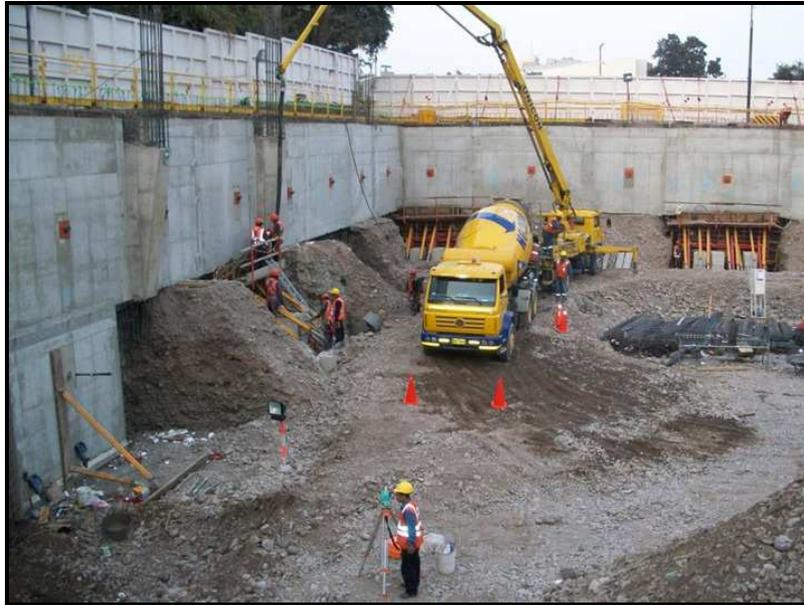
*Figura 27. Vaciado de muro anclado.*
