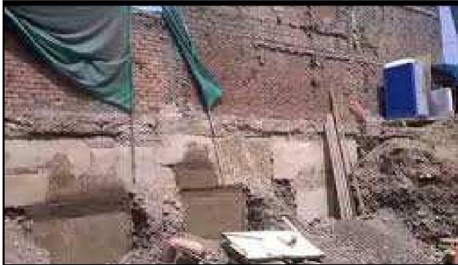
*Figura 8.* Desencofrado de calzaduras.
