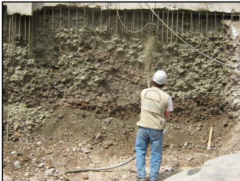
Figura 23. Pañeteo de talud con lechada de concreto.
