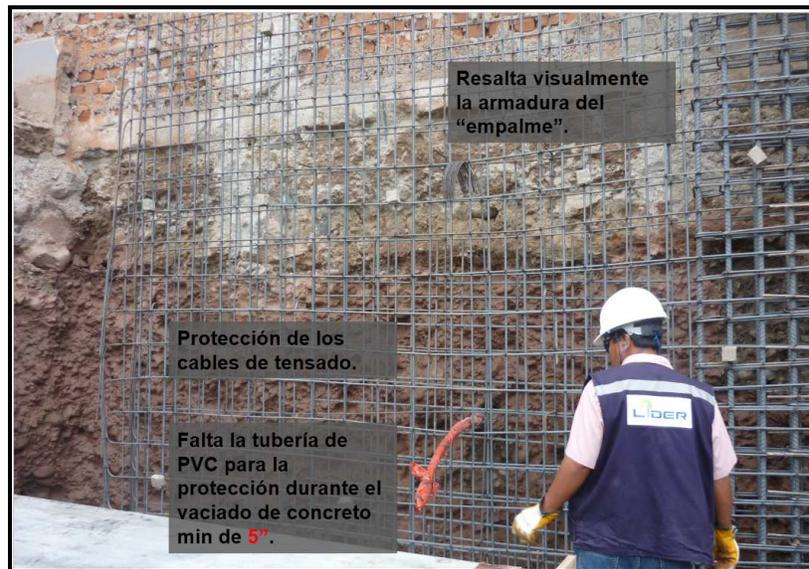
Figura 24. Colocación de enmallado de acero.
