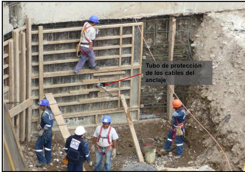
*Figura 25. Encofrado de muro anclado.*
