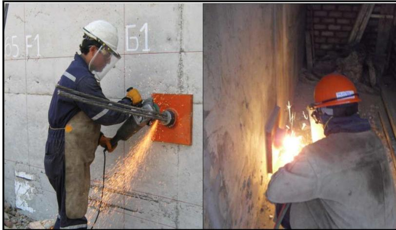
*Figura 30.* Destensado de anclajes.
