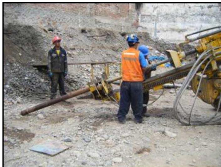
*Figura 16.* Armado de taladro y casing.
