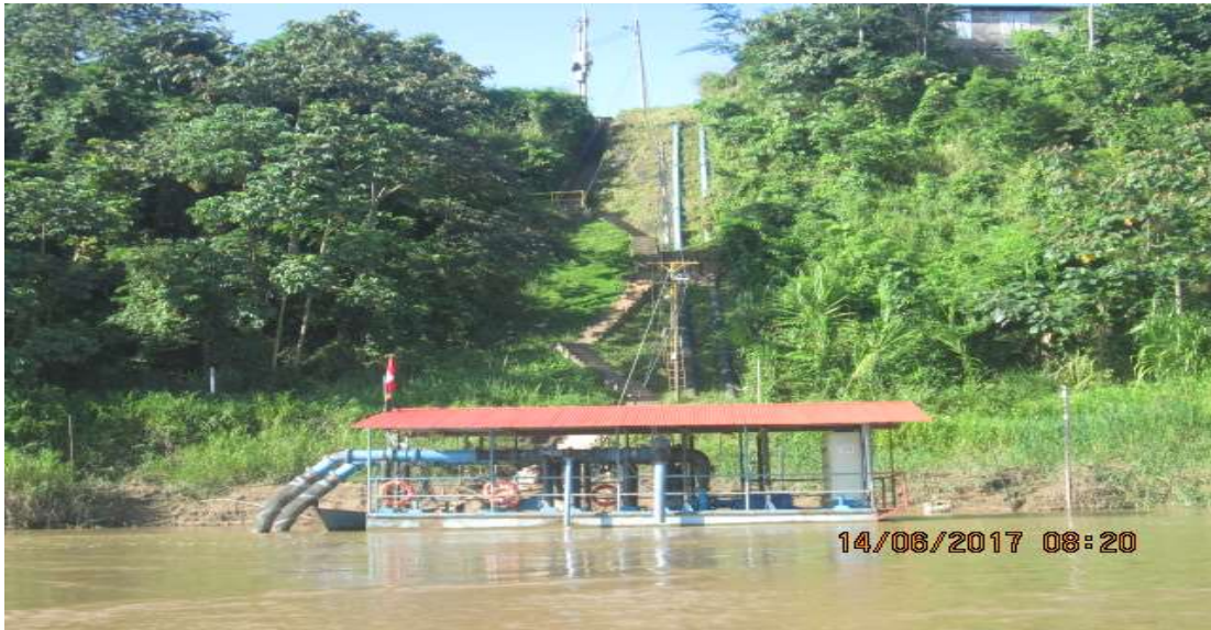
Foto 07: Zona de captación de EPS “Planta La Pastora”
