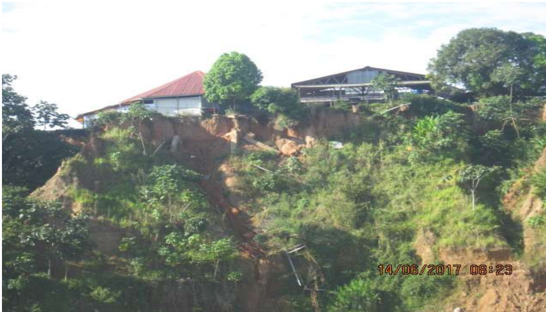
Foto N°08: Zona de riesgo en la Zona de captación La pastora”.
