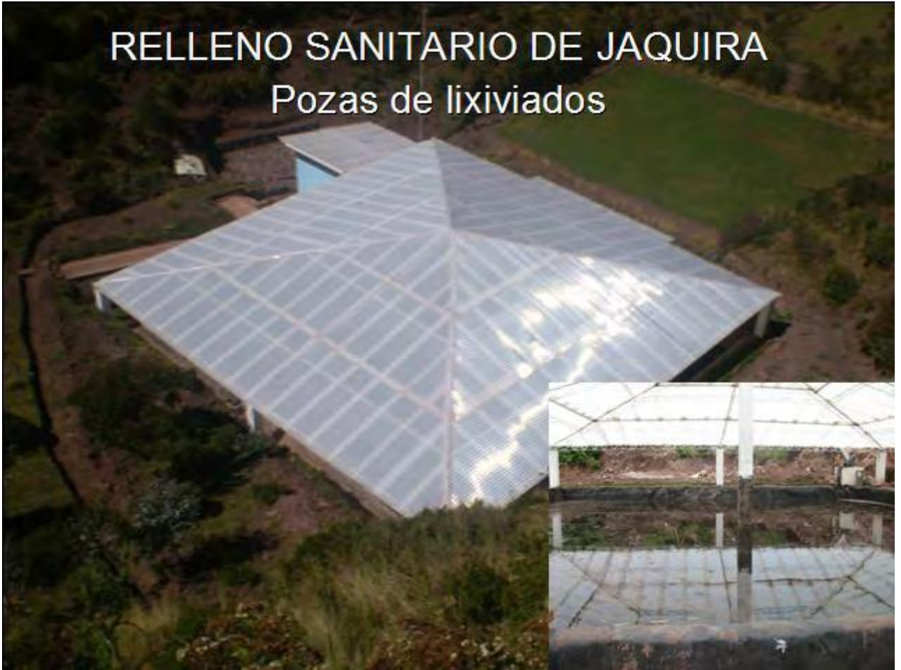
6.- Poza de lixiviados del relleno sanitario de Jaquira
