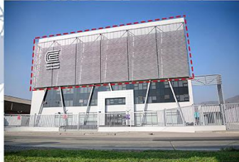
ACERO ESTRUCTURAL Y CELOSIAS
