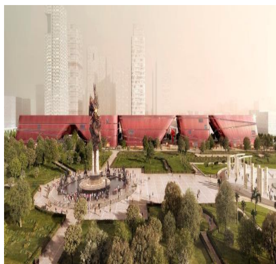
Figura 12. Vista aérea del Centro Cultural de MECANOO (Fuente: Metalocus)
