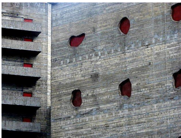
Figura 23. Muro del Centro Cultural SESC (Fuente: Archdaily)
