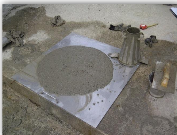
Figura 20: Ensayo de asentamiento del concreto en estado fresco.
