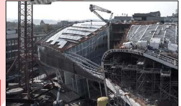
Cuenta con una ESTRUCTURA METÁLICA
