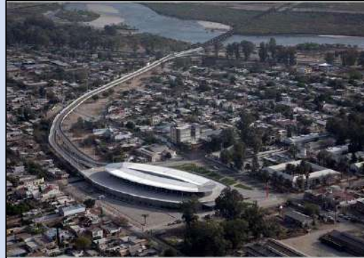
Dentro del entorno que rodea a este terminal Terrestre, se observa a viviendas que bordean al edificio.
