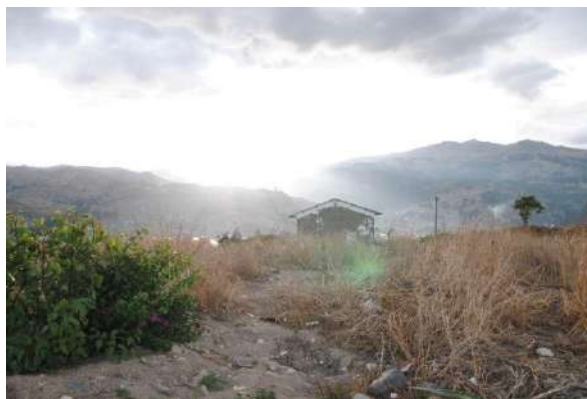
Figura 28: Pumacayan en el abandono.
