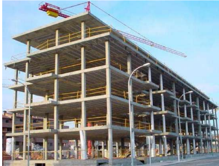
Figura 111: Sistema Constructivo Aporticado.
