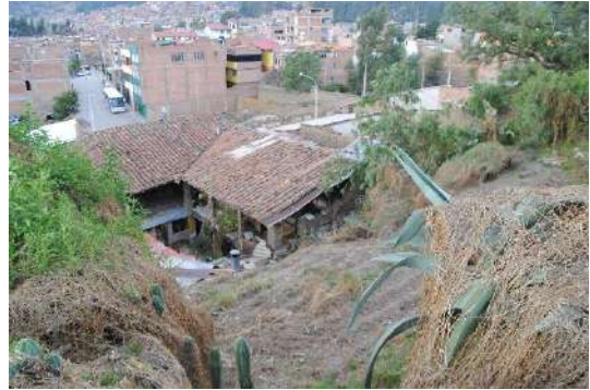
Figura 8: Vivienda invasiva enterrada en Pumacayan.
