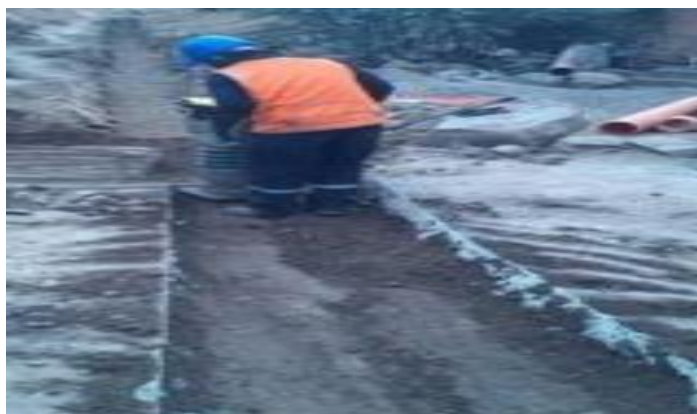
Figura 11. Compactación de zanja
