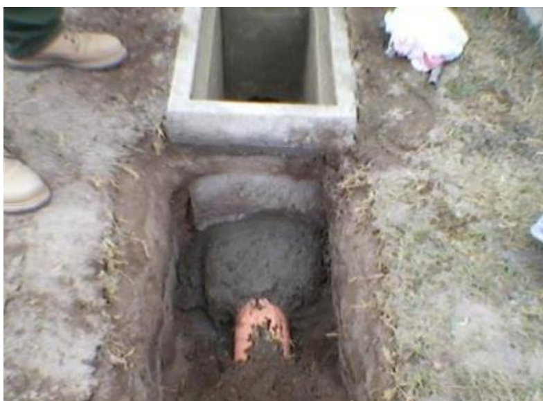
Figura 10. Emboquillamiento de tubería
