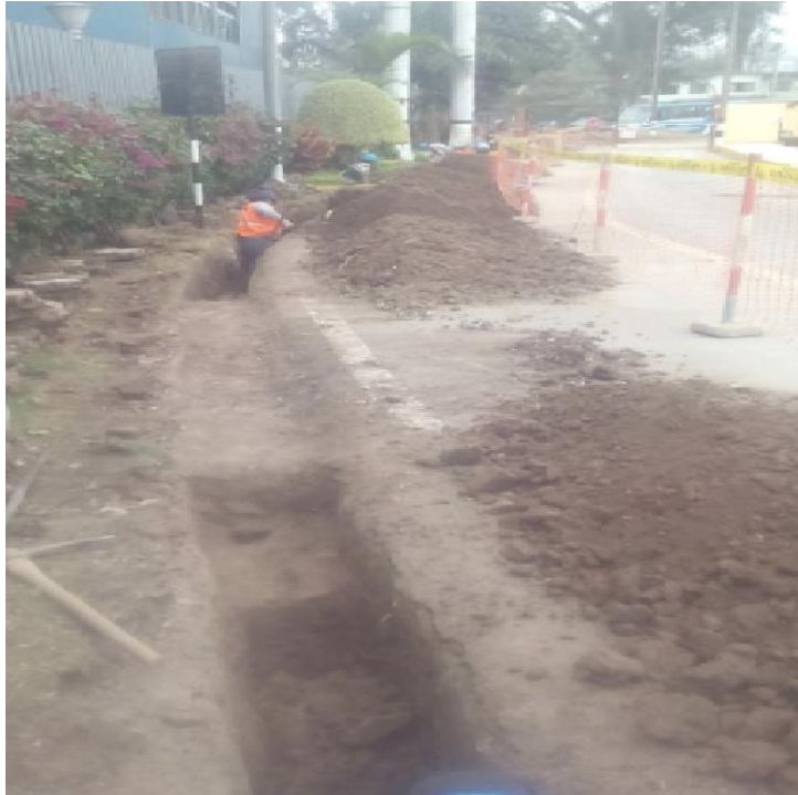
Figura 14: Trabajos de apertura de zanja
