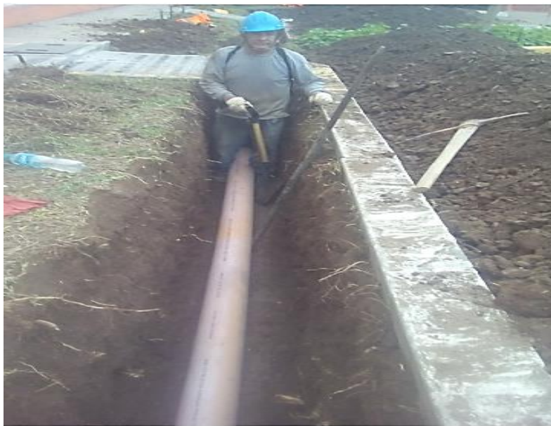
Figura 9. Alineamiento de tuberías
