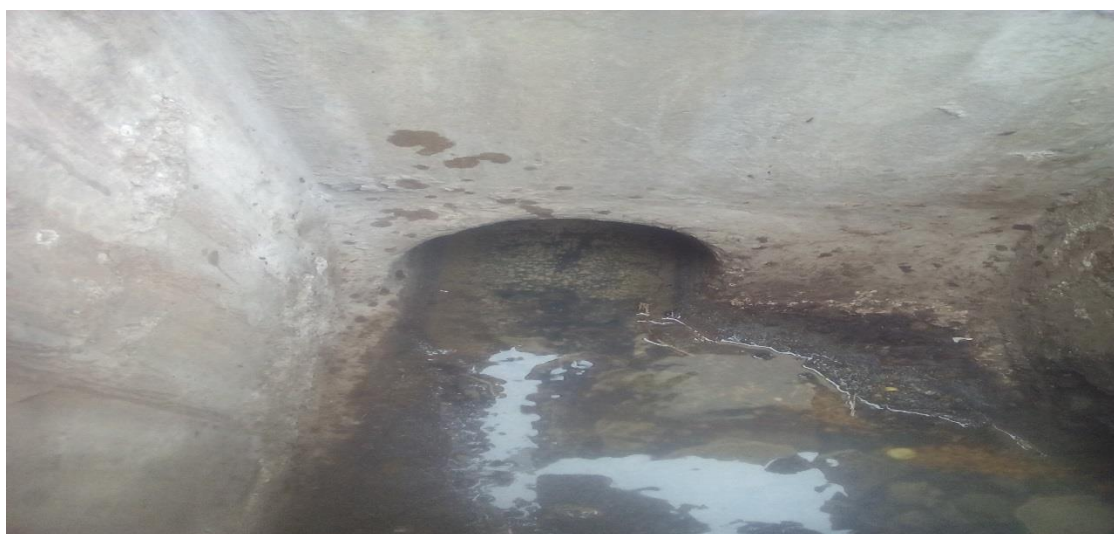
Figura 6. Vista de tubería de concreto red de desagüe 2 del centro internacional de la papa
