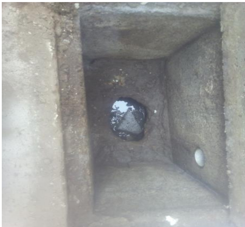
Figura 13: Caja de registro y tubería de concreto con material de construcción
