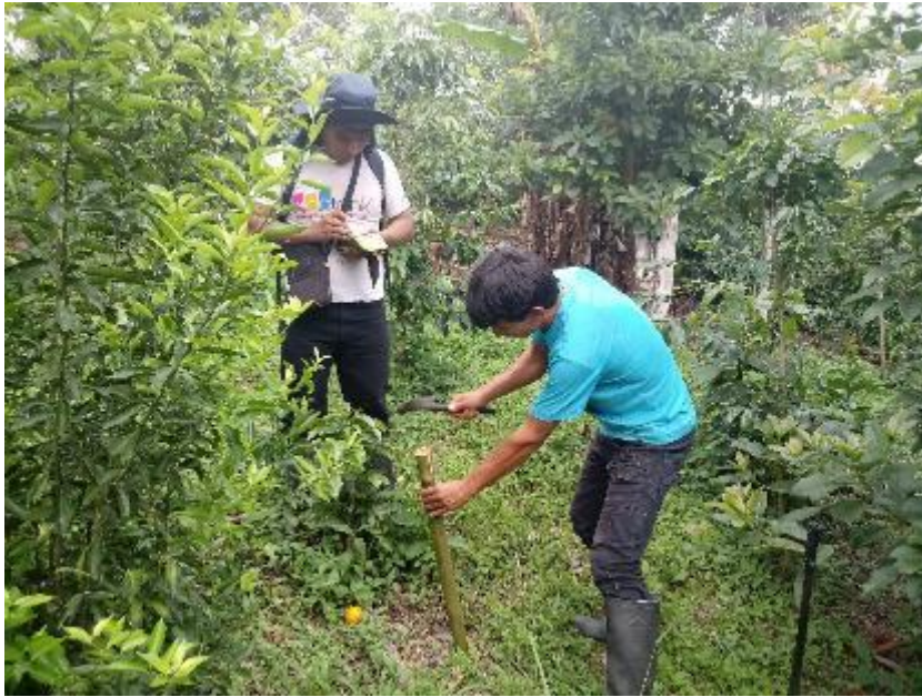
Toma de puntos en la línea de aducción mediante el GPS diferencial trimble y colocación de estacas de las progresivas
