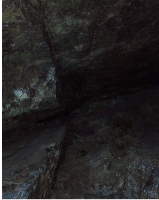
Falla en el frente de producción
