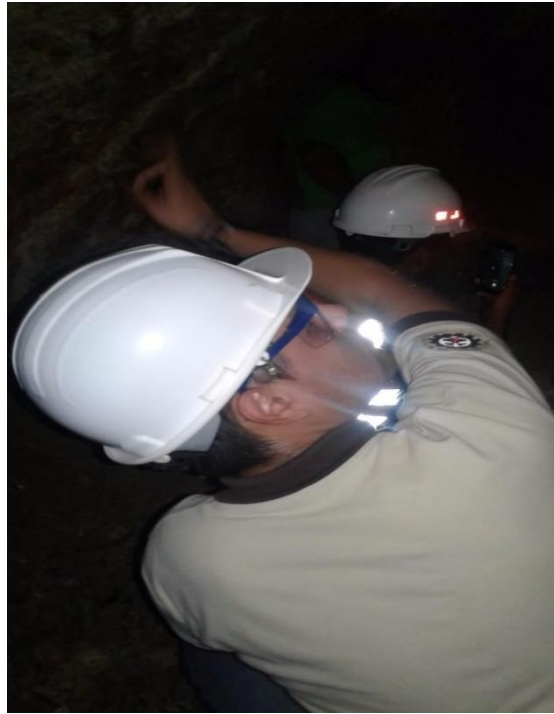
Observación del fracturamiento de la roca.
