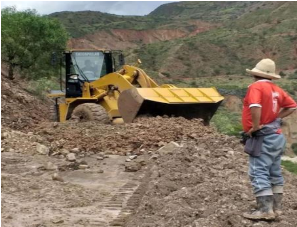
Maquinaria realiza la remoción de materiales blandos y personal asistente del operador de la maquina sin implementos de protección personal.
