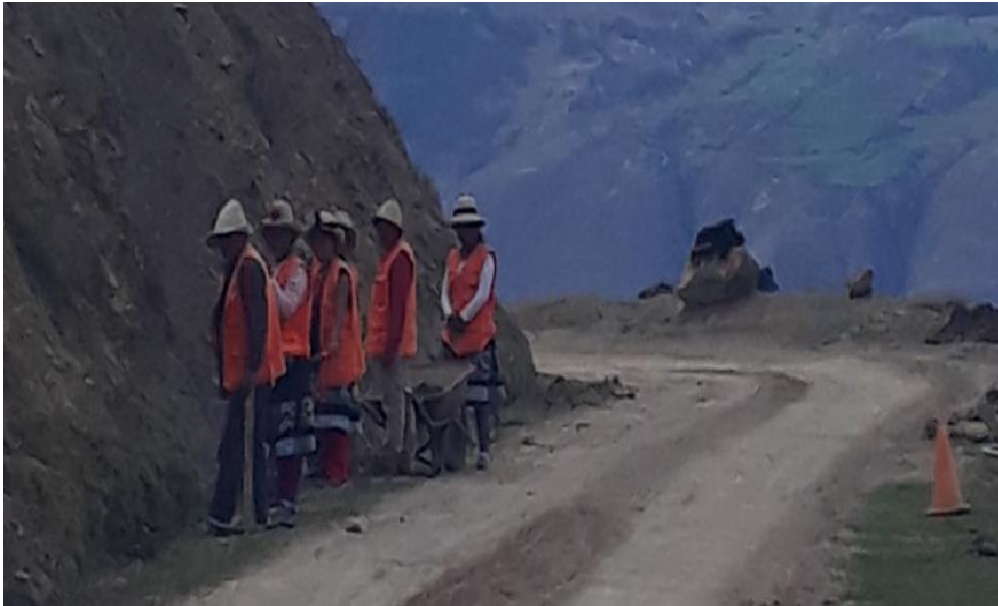
Personal realizando actividades de excavación
