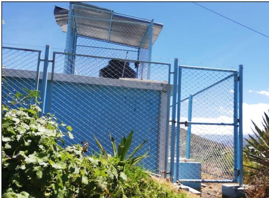
**Fotografía 08:** Reservorio rectangular, apoyado; se puede observar que, de acuerdo al estado de funcionamiento del reservorio, su estado es regular, presentando agrietamientos en las paredes, este reservorio requiere de una escalera para el ingreso al exterior del reservorio donde se ubica su sistema de cloración por goteo. (Abril – 2019)
