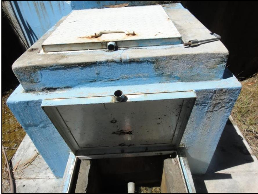
**Fotografía 05:** En la captación 3 (Inchiquita), se puede observar fisuras, así mismo se observa el desprendimiento del recubrimiento de la pintura. (Abril – 2019).
