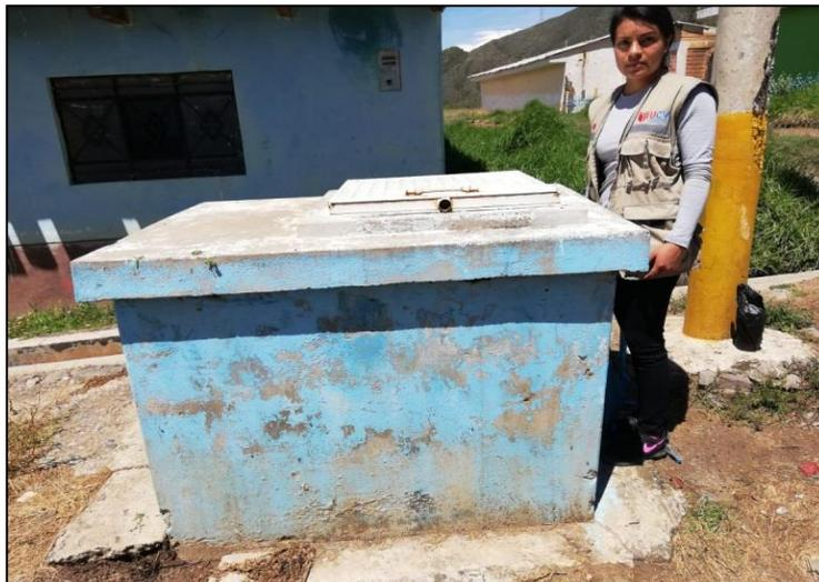
**Fotografía 10:** En el CRP7 se puede observar el desprendimiento del recubrimiento de la pintura. (Abril – 2019).
