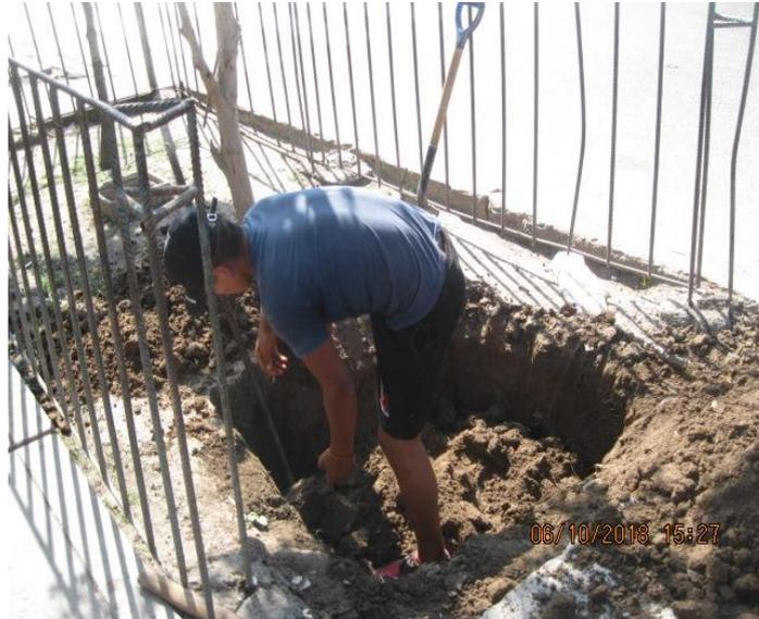
*Figura 131. Excavación de calicata N°01, Hospital Naylamp.*
