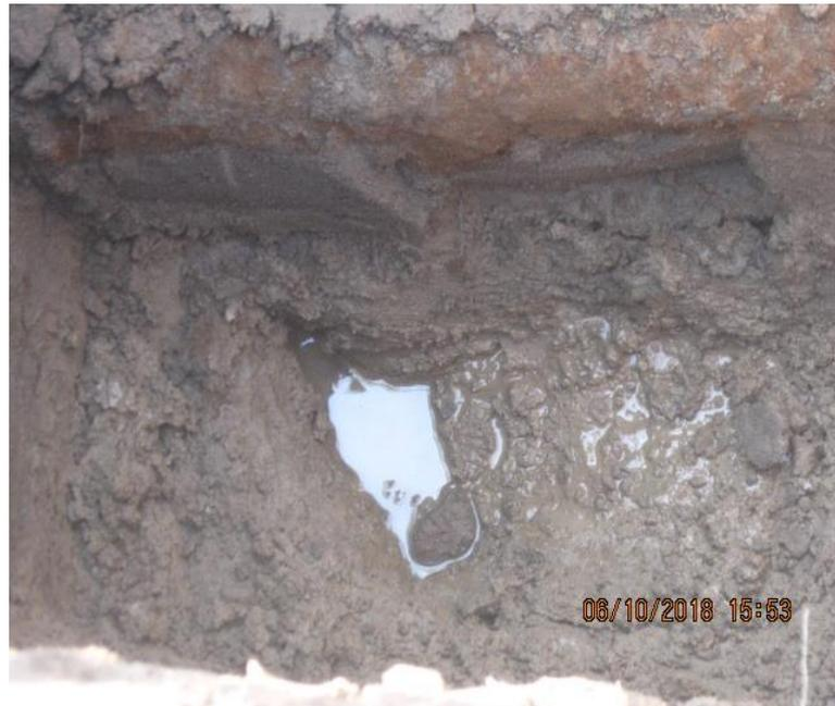
*Figura 137. Presencia de napa freática en estrato N°3, Hospital Naylamp.*
