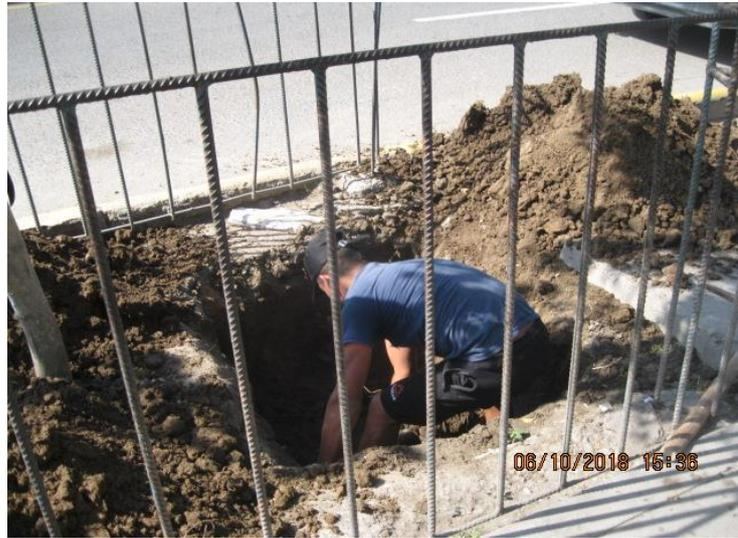
*Figura 133. Excavación de calicata N°01, Hospital Naylamp.*
