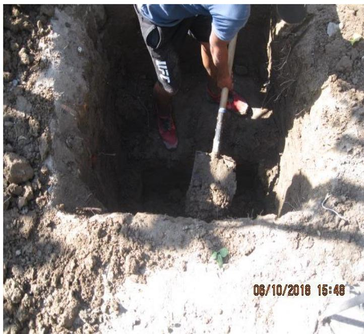
*Figura 136. Excavación de calicata N°01, Hospital Naylamp.*
