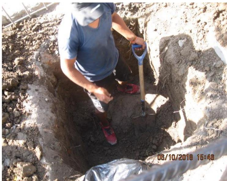
*Figura 135. Excavación de calicata N°01, Hospital Naylamp.*
