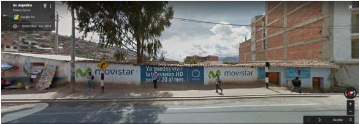
Figura 01. Google (2013) muestra la carencia de vereda de concreto u otro material. El desagüe es una canaleta.
