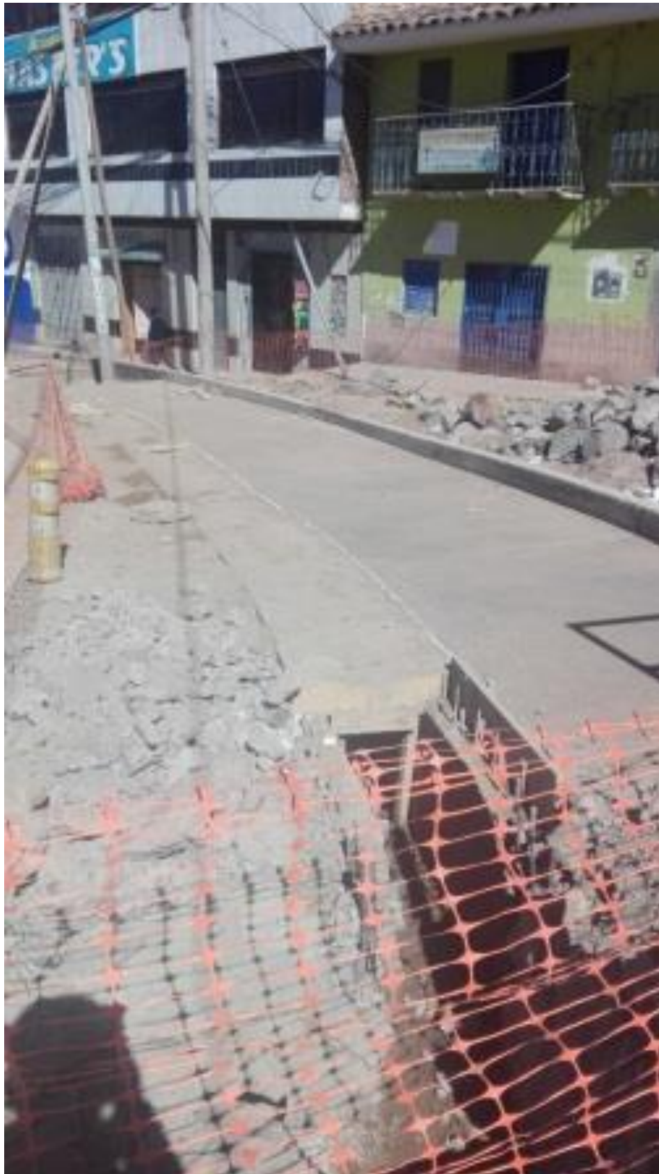
Figura 14. De fuente propia, se observa el mejoramiento del paradero mencionado en figura 13.
