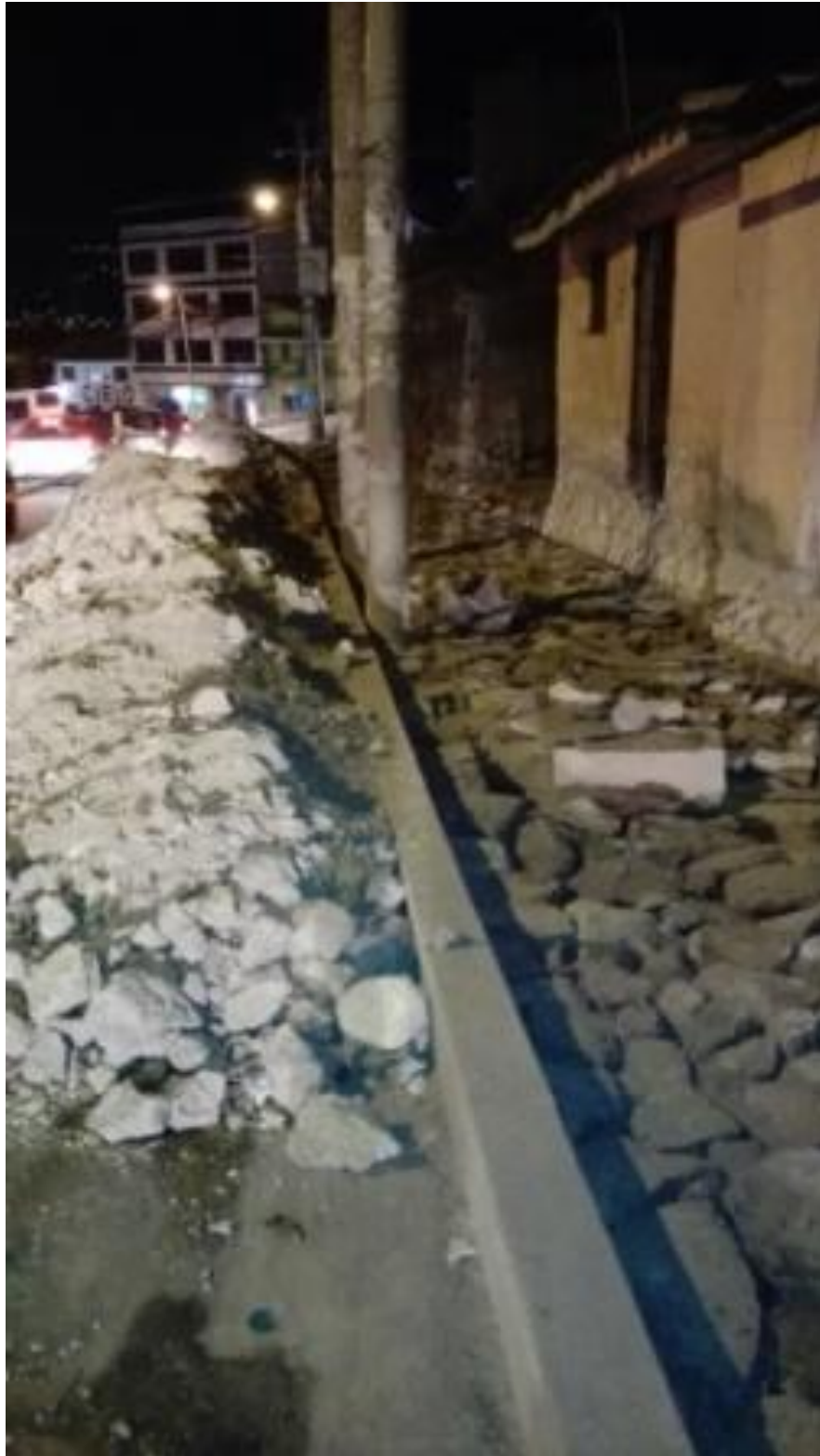
Figura 11. De fuente propia, se aprecia el empedrado para su posterior cubierta con concreto.
