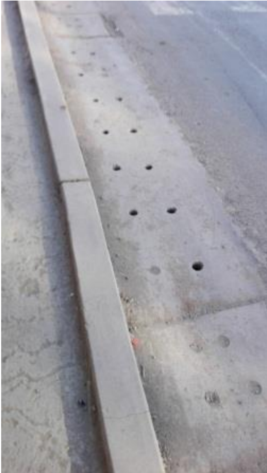
Figura 16. Mejoramiento de los desagües, que ahora lucen cubiertos antes presentaban otra apariencia
