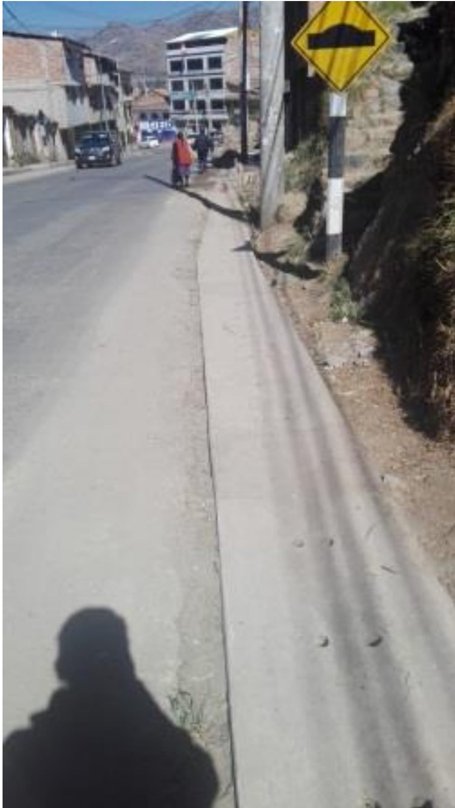
Figura 19. De fuente propia, se observa otro tramo de Avenida Argentina con desagües cubiertos.
