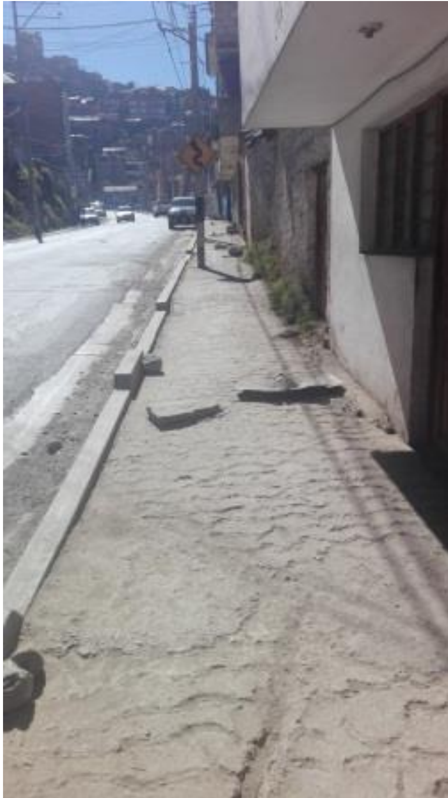
Figura 20. Tramo de Avenida Argentina cubierto en concreto, ya no muestra diversos diseños. Los desagües están cubiertos.
