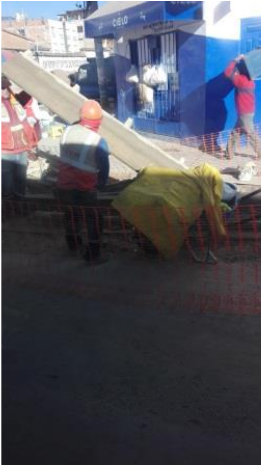
Figura 13. De fuente propia, se tiene los obreros en la construcción de la acera del paradero Ucchullo.
