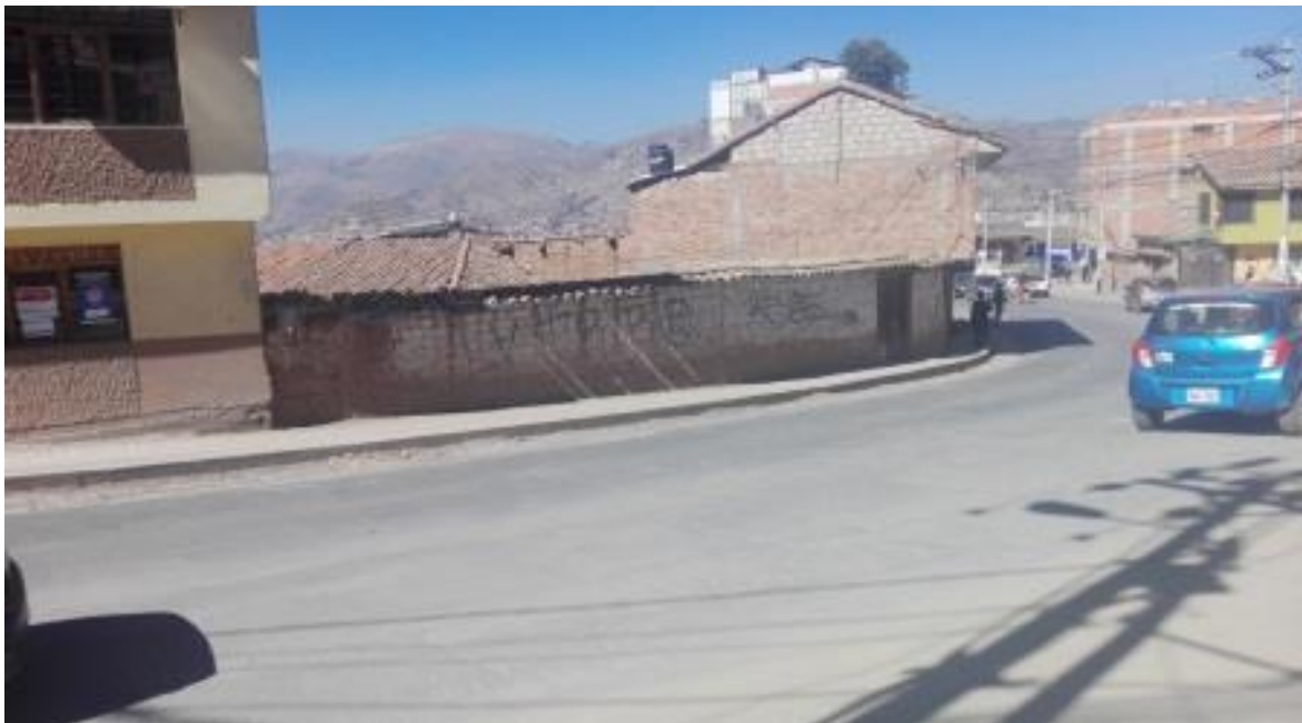
Figura 22. De fuente propia, comparado con la figura 2, se muestra una mejora notable de este fragmento de la Avenida Argentina.
