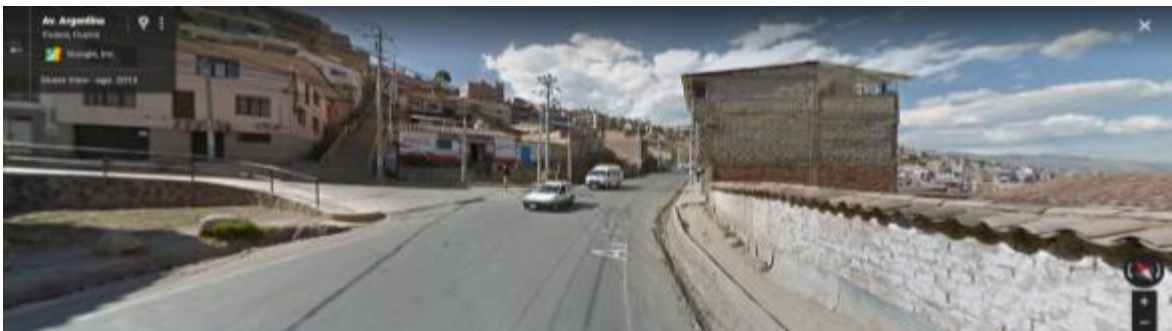
Figura 2. Google(2013) muestra a la derecha la canaleta de desagüe descubierta, también la acera es de tierra hasta unos metros mas adelante. El muro contigüo ha sido reconstruido pues invadía la acera.
