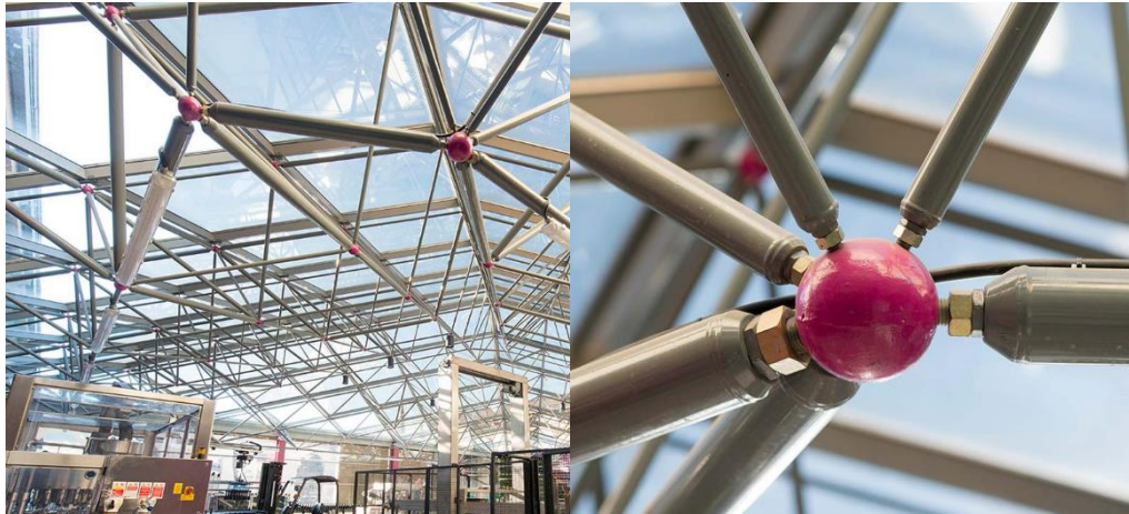
Figura 18: Estructuras espaciales con detalles de unión de barra y esfera. Recuperado de https://kotoingenieros.es/construccion-madera/estructuras-espaciales/
