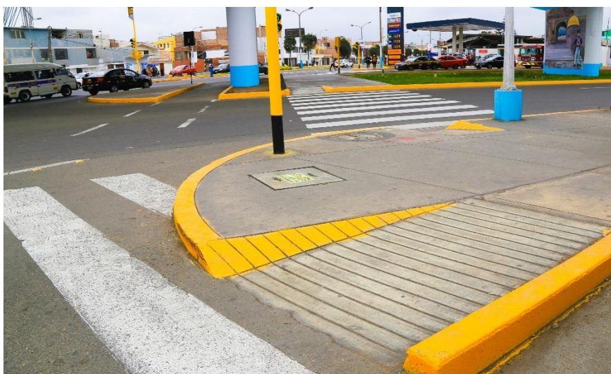
Figura 21: Rampa de acceso para discapacitados en principales avenidas del Callao. Recuperado de http://www.municallao.gob.pe/index.php/noticias/2055-callao-inclusivo-construyen-rampas-de-acceso-para-discapacitados-en-principales-avenidas
