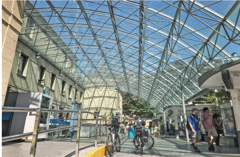
Figura 7: Cubierta espacial Euskotren. San Sebastián, España. Recuperado de http://www.lanik.com/es/estacion-euskotren
