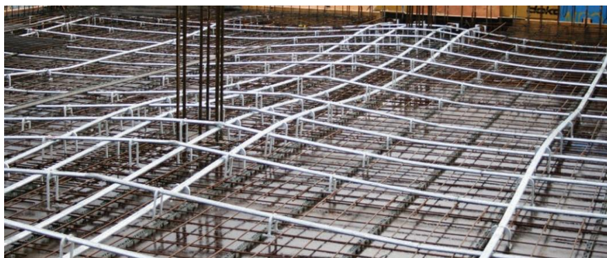
Figura 20: Estructura de losas Postensadas. Recuperado de https://fr.cclint.com/uploads/PDFs/Slabs-Brochure-Spanish.pdf
