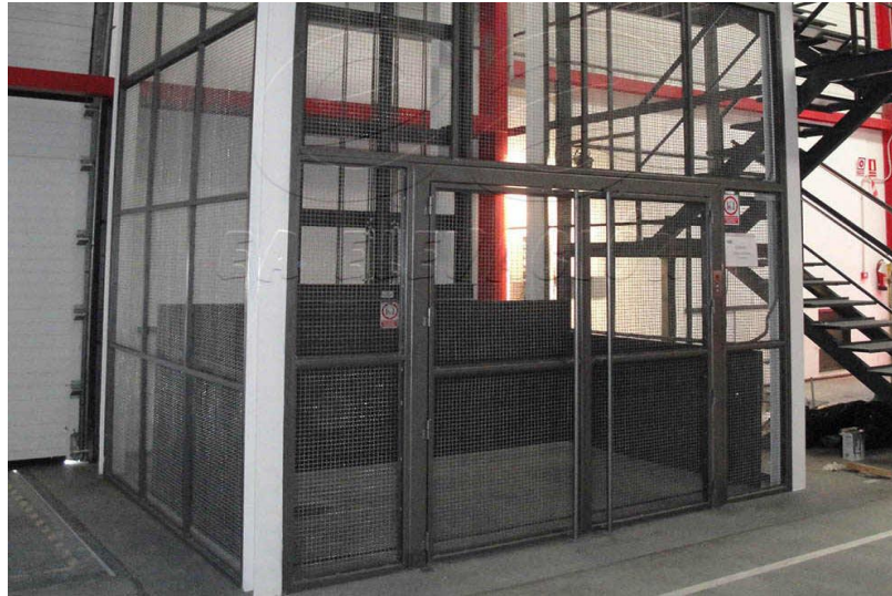
Figura 19: Instalación de montacargas en Málaga. Recuperado de http://eaelevacion.es/wp-content/uploads/2014/06/instalacion-montacargas-en-malaga-3.jpg?x24067
