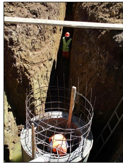
Imagen N° 3 confección de cámara in-situ para alcantarillado convencional. Fuente: obra Acobambilla, 2017.
