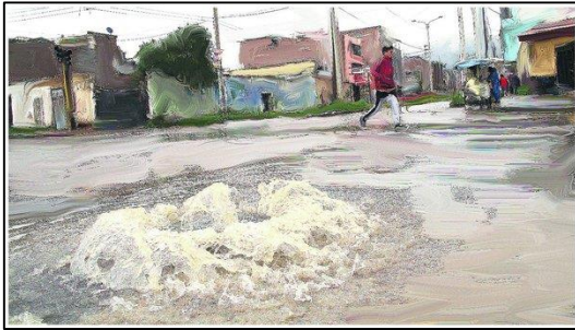
Imagen N° 4 muestra problemas de rebalse y uno de los problemas de obstrucción.
