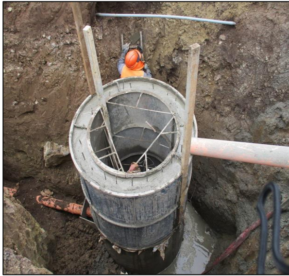
Imagen N° 3 confección de cámara in-situ para alcantarillado convencional. Fuente: obra Acobambilla, 2017.
