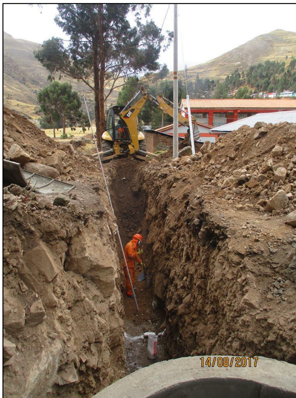
Imagen N° 1 excavación con maquinaria para instalación de tuberías en alcantarillado convencional. Fuente: obra Acobambilla, 2017.
