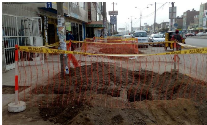
Figura 4: Señalización area de trabajo
