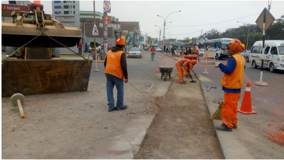
Figura 11: Relleno y compactación
