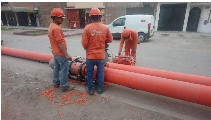
Figura 6: Termo fusión de tuberías
