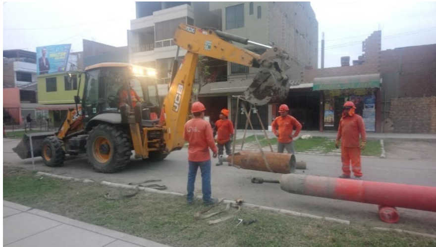
Figura 8: Colocación de cabezal
