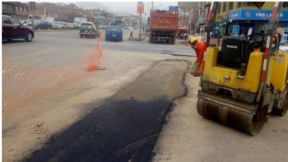
Figura 12: Reposición e asfalto.
