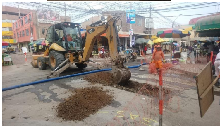
Figura 5: Excavación de Ventanas
