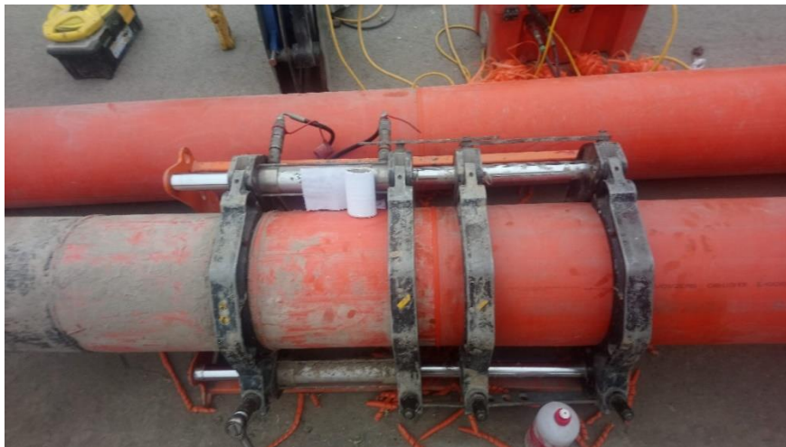
Figura 7: termo fusión de tuberías
