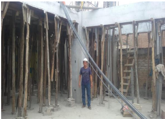
Foto 1. Encofrado de techo
