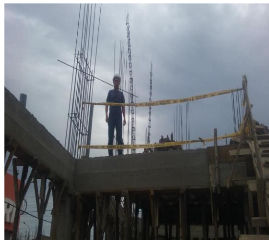
Foto 4. Encofrado de escalera
