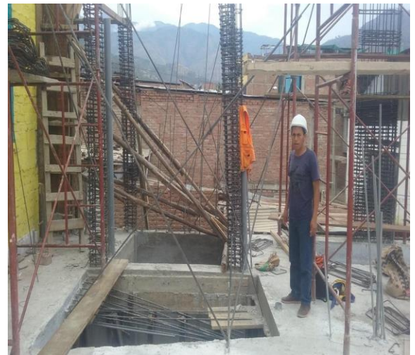
Foto 6. . ARMADURAS DE ACERO PARA COLUMNAS
