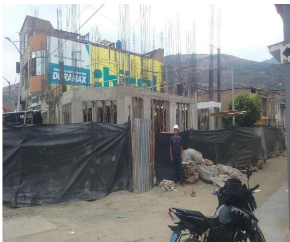
Foto 3. Encofrado de vigas
