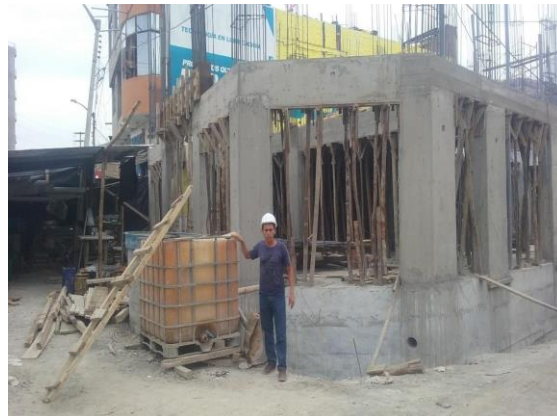
Foto 2. Trabajos programados de encofrado
