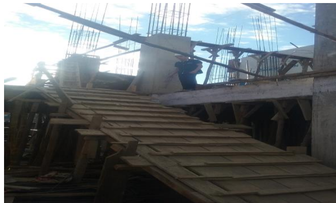
FOTO 7. . ARMADURAS DE ACERO PARA COLUMNAS
