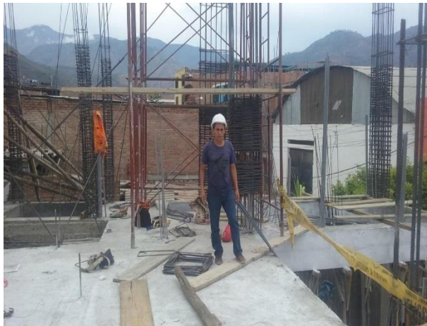
Foto 5. . VACIADO DE LOSA MACIZA
