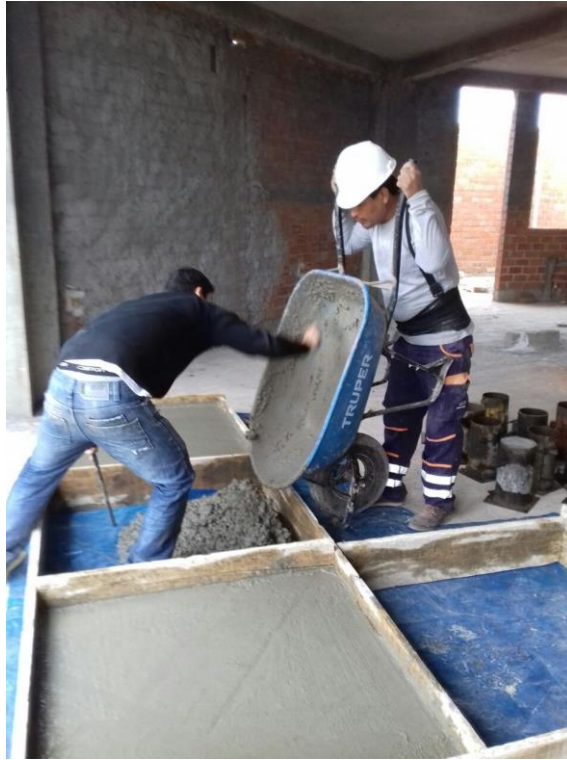
Figura 18: Vaciado de losas de concreto.
