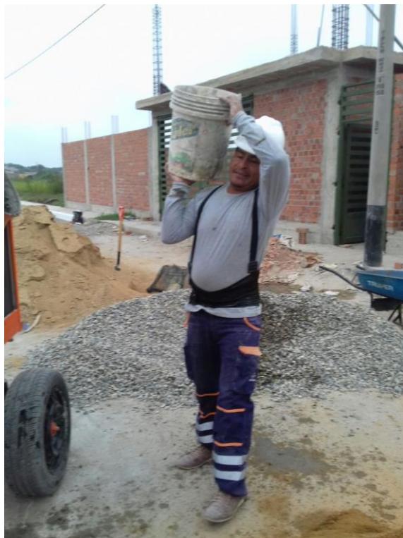
Figura 16: Colocación de agregado en la mezcladora tipo trompo.
