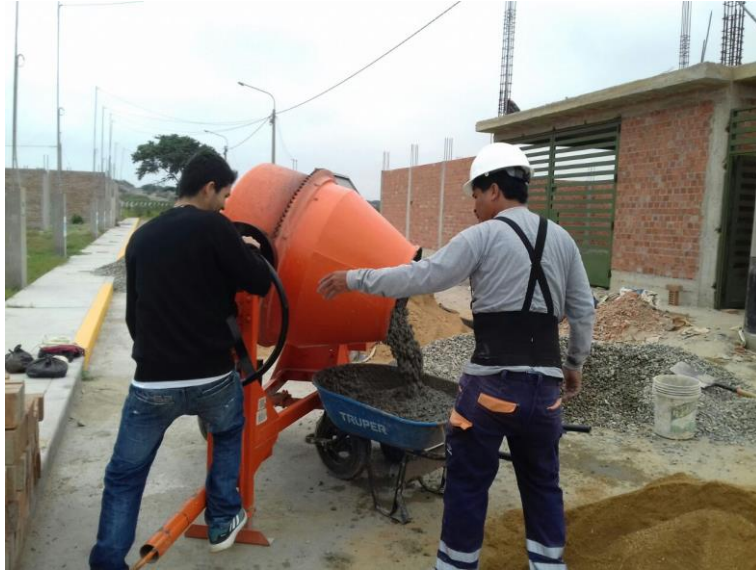
Figura 17: Preparación de mezcla de concreto f'c = 210 \text{ Kg/cm}^2 .
