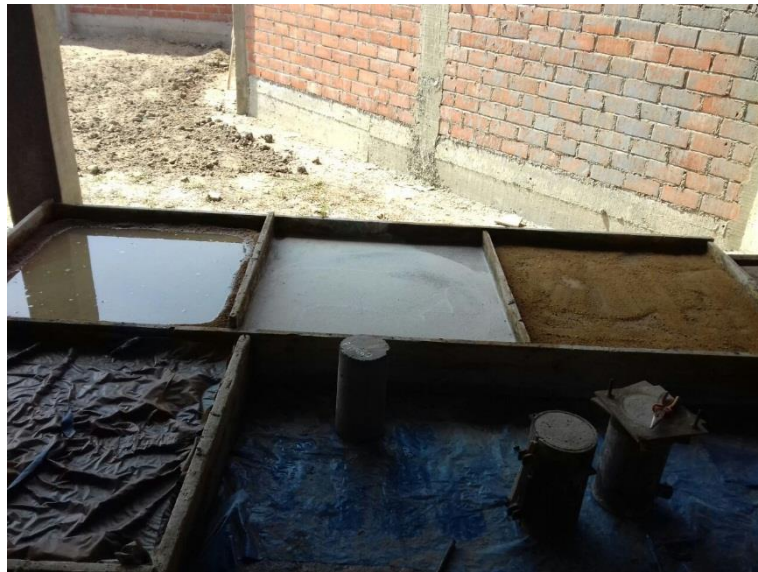
Figura 22: Losas bajo distintos curados.
