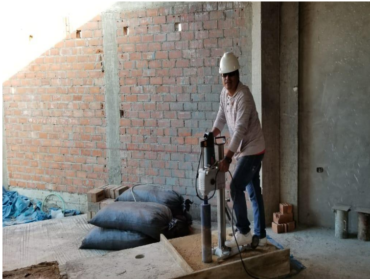
Figura 38: Extracción de testigo con diamantina losa curada con arena humada
