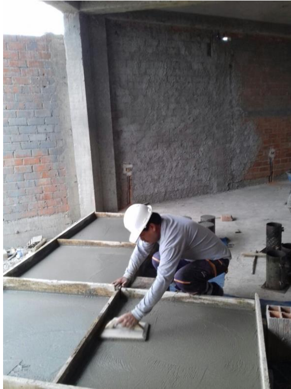
Figura 27: Acabado de losa a ensayar.
