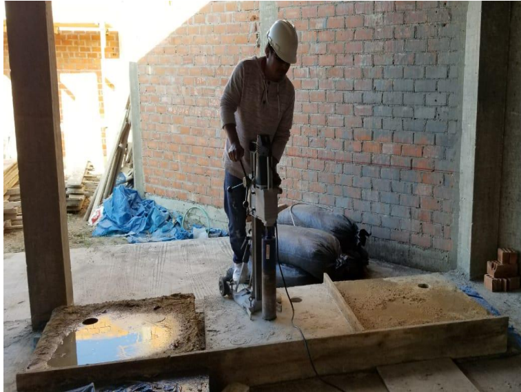
Figura 37: Extracción de testigo con diamantina losa curada con aditivo
