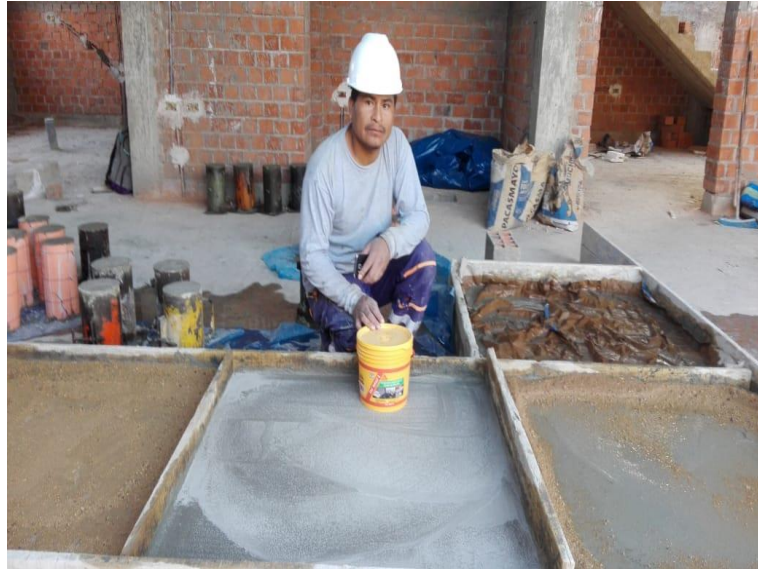
Figura 29: Habilitación de aditivo para curado.
