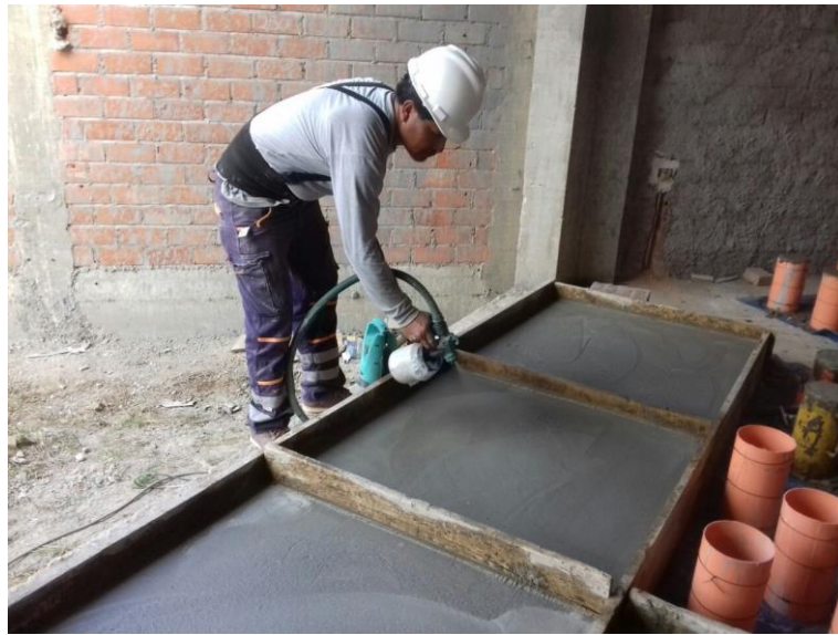
Figura 26: Curado con aditivo.
