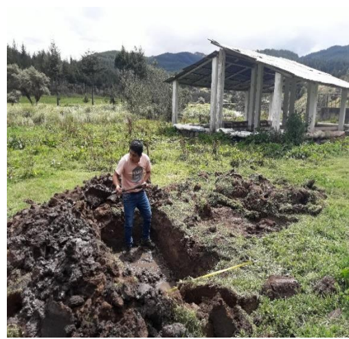
Foto N° 6: Segundo día trabajos respectivos
