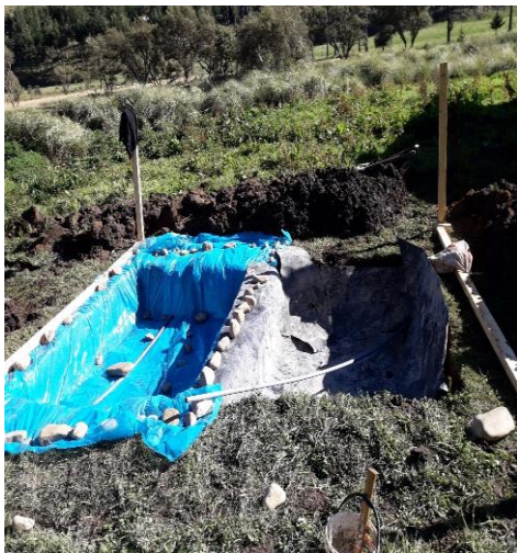
Fotos N°7 Instalación con geomenbrana
