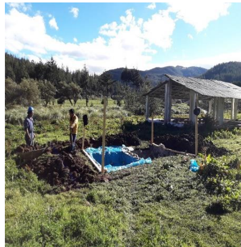
Fotos N°8 Instalación de postes
