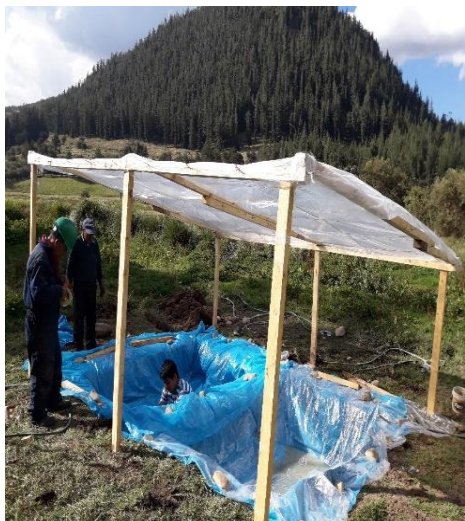
Fotos N°9 Instalación pegando plásticos
