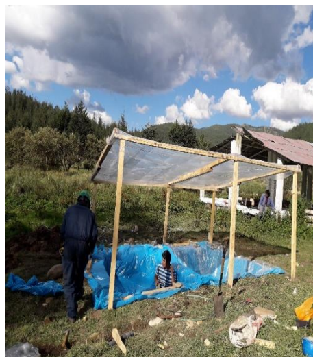
Fotos N°10 Instalación pegando plásticos
